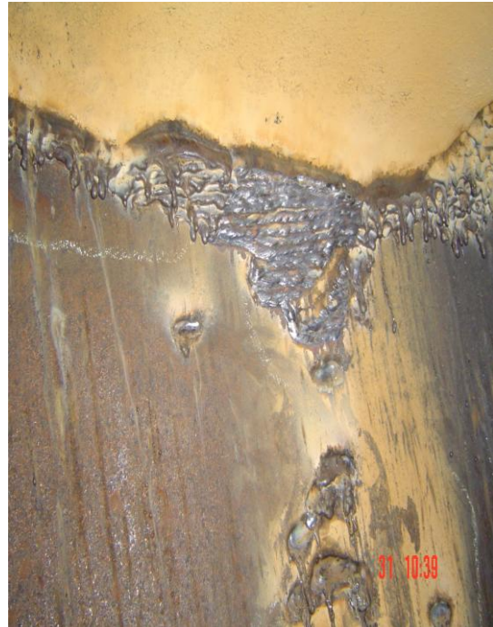
Resim 9. Keban HES çark kaynağı
