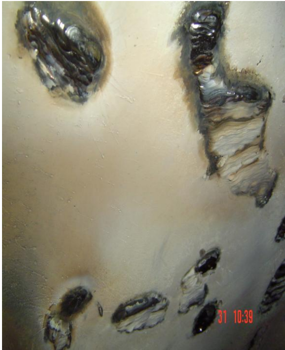
Resim 8. Keban HES çark kaynağı
