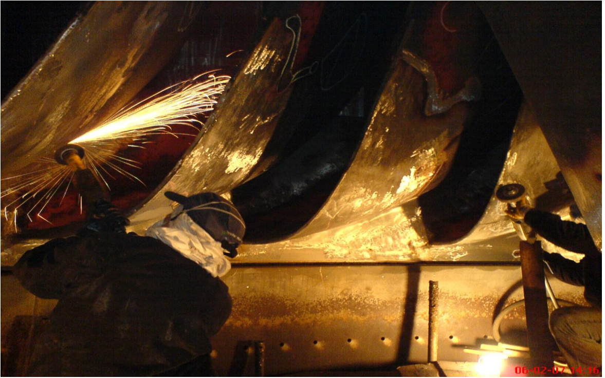
Resim 15-16. Karakaya HES çark kanatlarının kaynak ve taşlaması.
