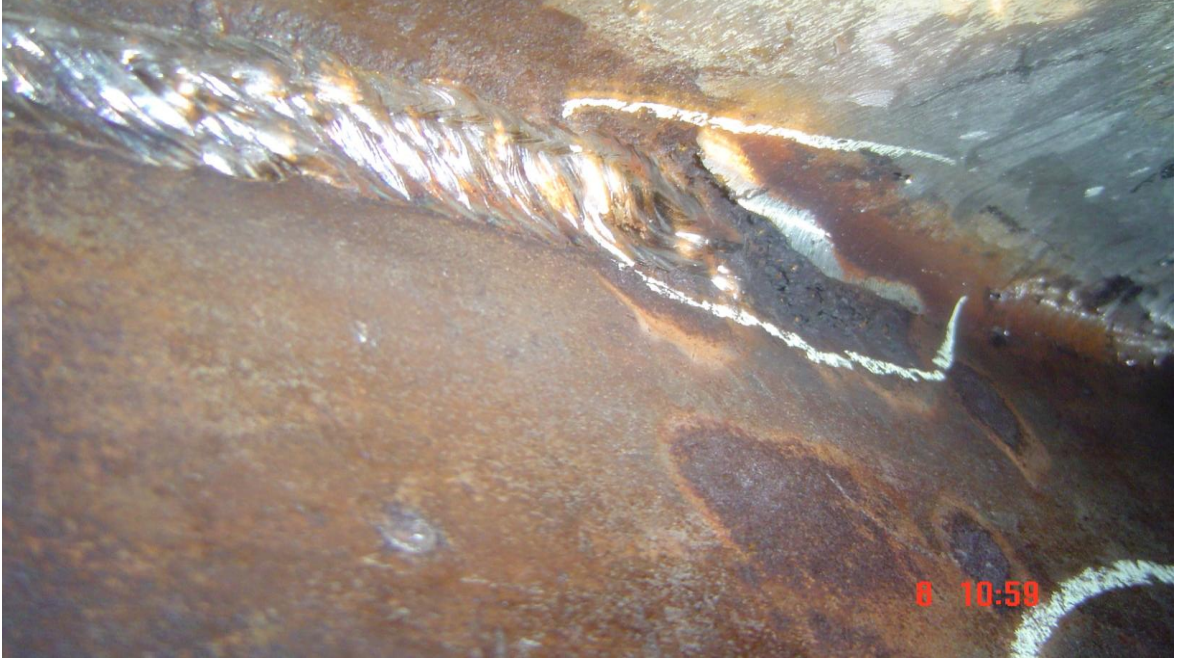
Resim 10. Keban HES çark kaynağı
