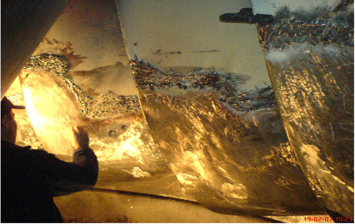
Resim 4. Türbin çark kanatları kaynak çalışması.
