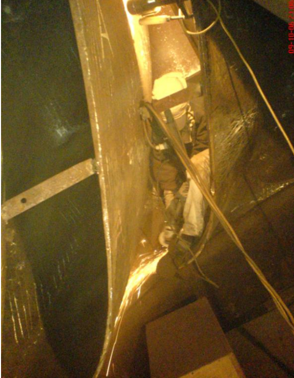
Resim 18. Bakım personeline çarkın taşlanması Resim 19. Üzerinde oyuklar oluşmuş, taşlanmış çark yüzeyi
