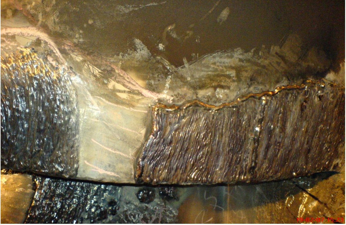
Resim 5. Türbin çark kanatları kaynak çalışması.
