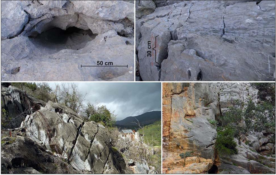
Foto 56. İnceleme alanında Tersiyer yapıları hariç diğer karstik litolojiler bol çaylaklı olduğu için çatlak lapyalarının gelişiminde Paleozoik ve Mesozoik karbonatlı yapıları ön plandadır
