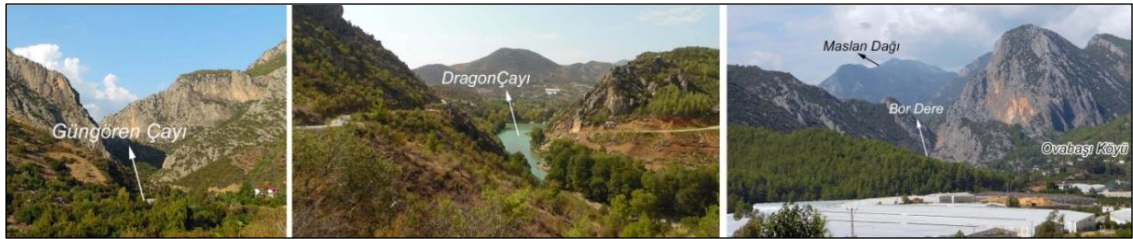
Foto 16. Çalışma alanında bulunan önemli yarma vadiler
