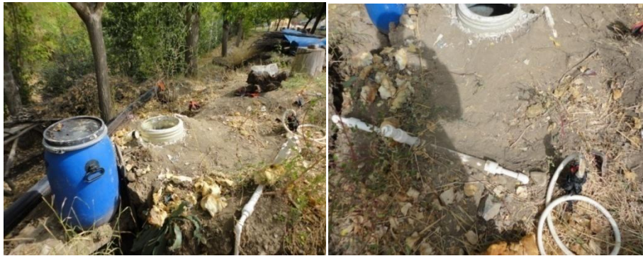
Şekil 3.16. Gazın depoya aktırılmasını sağlayan pvc borular
