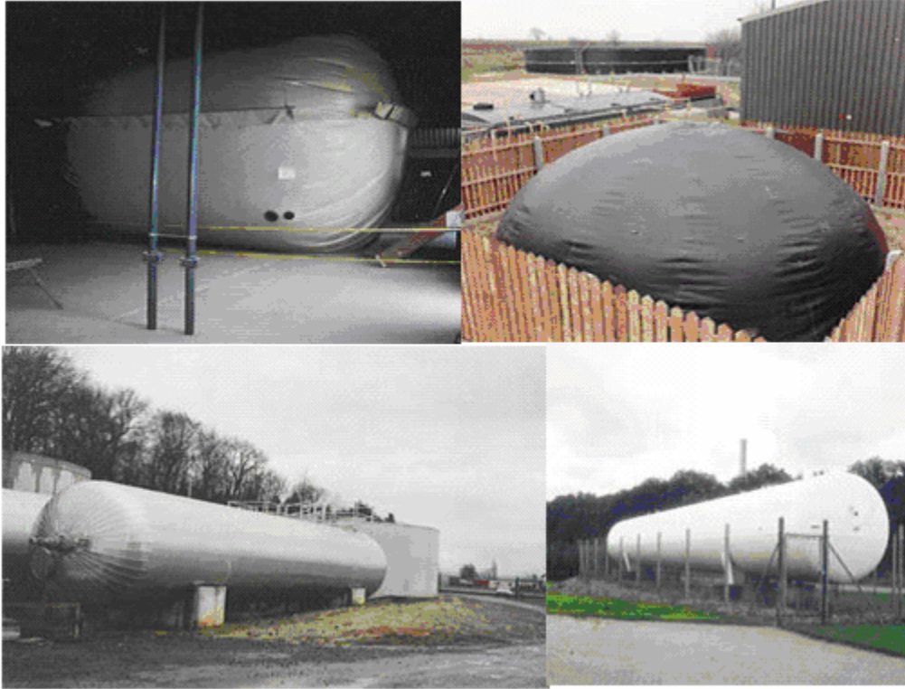
Şekil 2.10. Biyogazın depolanması [5]
