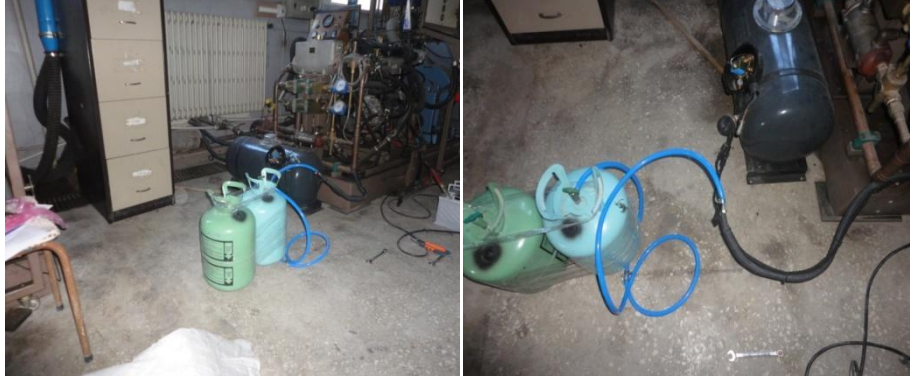
Şekil 4.2. Biyogaz dolu tüplerin LPG giriş rekoru sökölerek biyogaz hortumunun bağlanması
