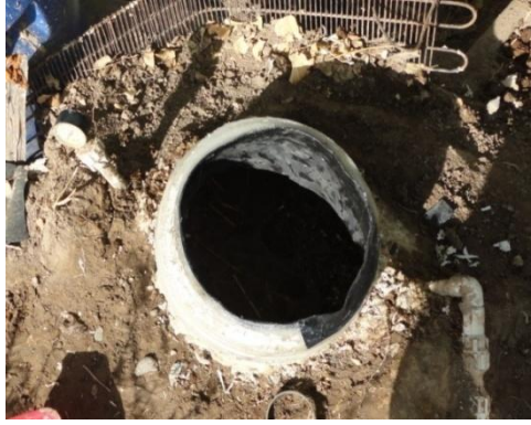
Şekil 3.12. Fermentörün kapak ağzının ve içten görünümü
