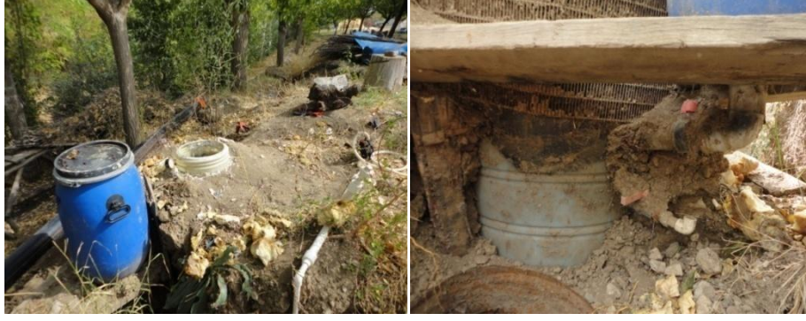
Şekil 3.7. Hammadde ekleme deposu ve fermentöre bağlanması
