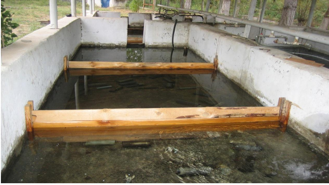
Şekil 2.4. Cip Balık Üretim Tesisleri’nde kerevitlerin bırakıldığı havuzlar
