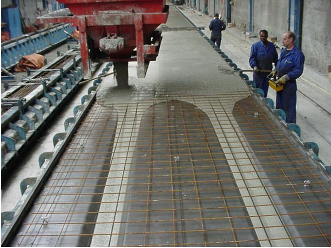
Şekil 2.1. Kendiliğinden Yerleşen Beton (KYB) [22].
