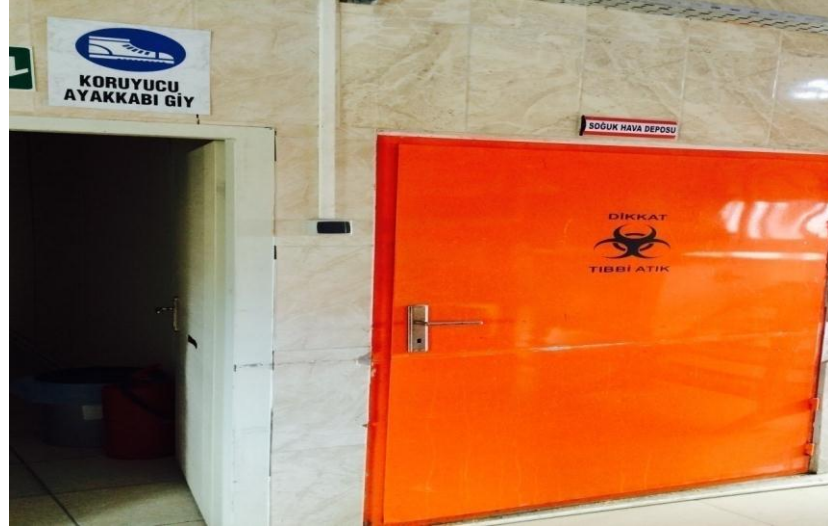
Şekil 3.8. Geçici atık deposu dıştan görünüm
