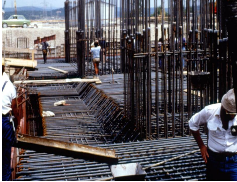
Şekil 2.2. Yoğun donatılı yerlerde KYB kullanımı [9].
