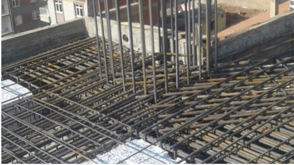
Şekil 3.15 Geniş kiriş-kolon birleşim bölgesi örneği
