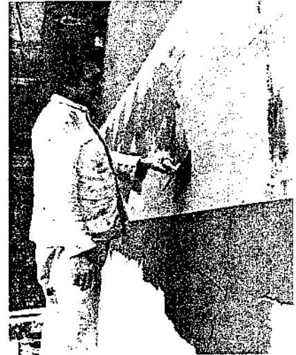
Resim :10 Duvarların dış taraftan yalıtımı
