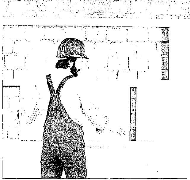
Resim : 6 Duvarların iç taraftan yalıtımı
