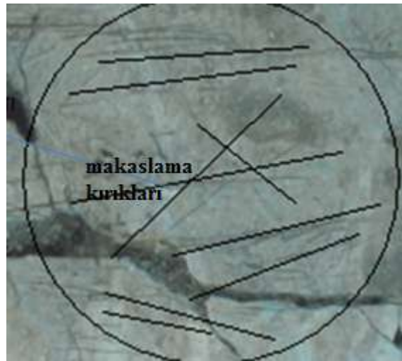
Şekil 4. 6. Kalkışist ve mermerlerde gelişen makaslama kırıklarının görünümü. Kilyan Köyü Kuzeyi.
