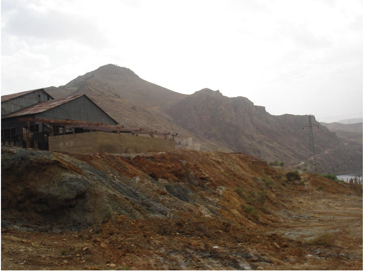
Şekil 4.1: Keban flotasyon tesisi yanındaki KY nolu atık sahasının arazideki görüntüsü.
