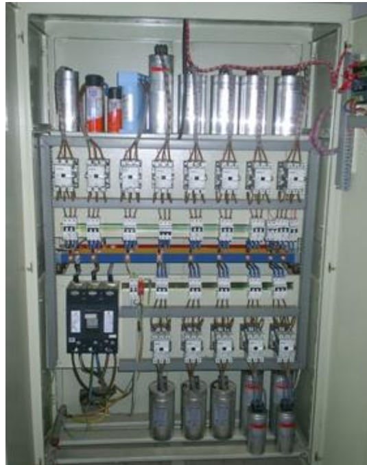
Şekil 4.26. FÜMET’de bulunan kompanzasyon sistemi
