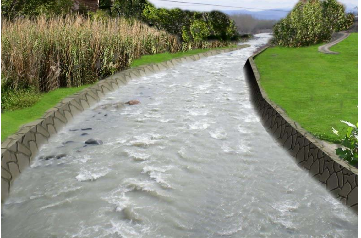
Foto 94.- Çapakçur Çayı vadisinin düzenleme – planlama çalışması sonrası durumu (Batıdan Görünüm)
