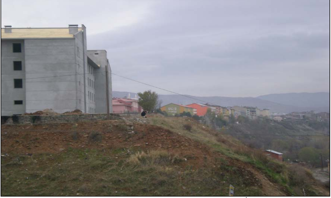
Foto 27.- Çapakçur Çayı vadisinin yamaçlarında yer alan betonarme konutlar (İnönü Mahallesi)
