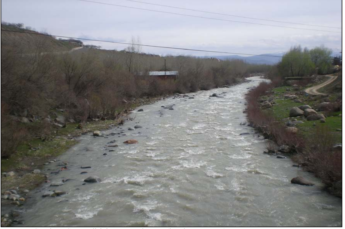
Foto 93.- Çapakçur Çayı vadisinin mevcut durumu (batıdan görünüm)
