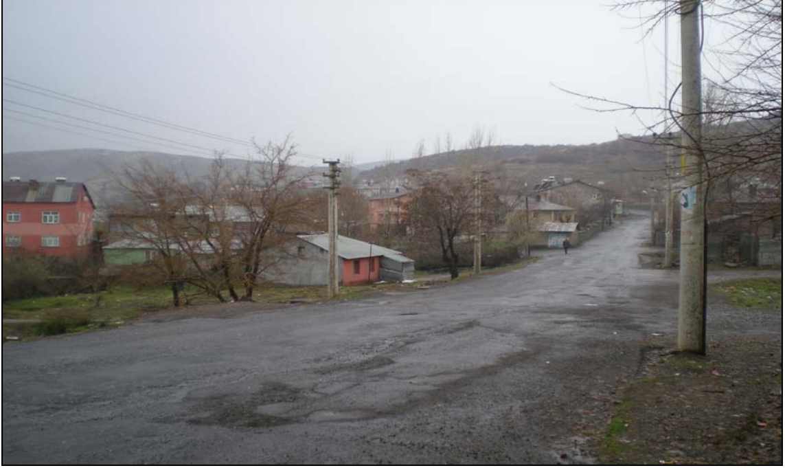
Foto 79.- Şehir içi ulaşım ağı elektrik ve telefon hatlarının konumlarından dolayı sık sık aksamaktadır (Yeşilyurt Mahallesi).
