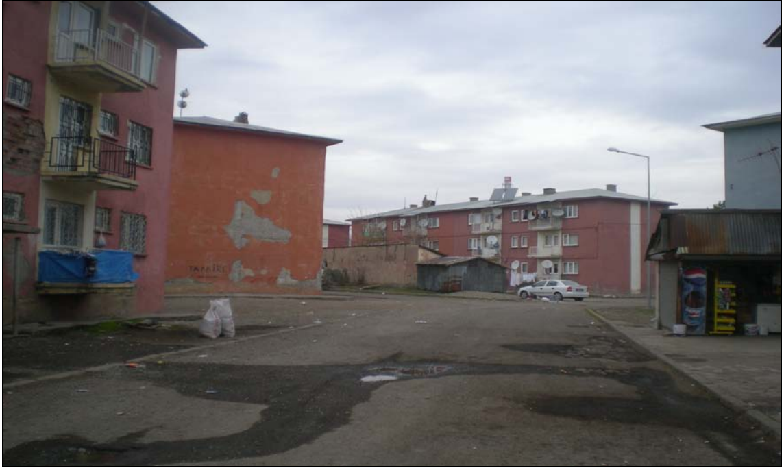
Foto 83.- İnönü Mahallesinde genel olarak 2 ve 3 katlı yapılar bulunmaktadır.
