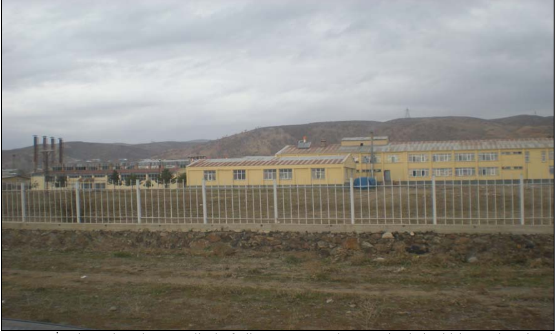
Foto 32.- İnceleme alanında uzun yıllardır faaliyet gösteren ve kamuya ait tek ticari işletme olan Bingöl Et ve Balık Kurumu tesisi (Kaleönü Mah.)
