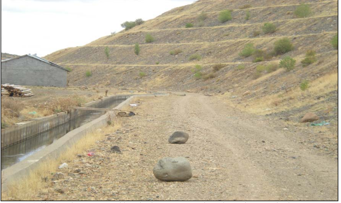
Foto 56.- Sekileme çalışmasının yapıldığı alanda zaman zaman kaya düşmesi yaşanmaktadır.
