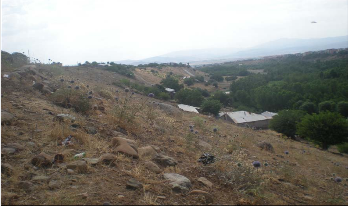
Foto 58.- Çapakçur Çayı vadisi yamaçlarında yaşanan kaya düşmeleri bölgedeki yapılara büyük tehdit oluşturmaktadır (Bahçelievler Mahallesi)
