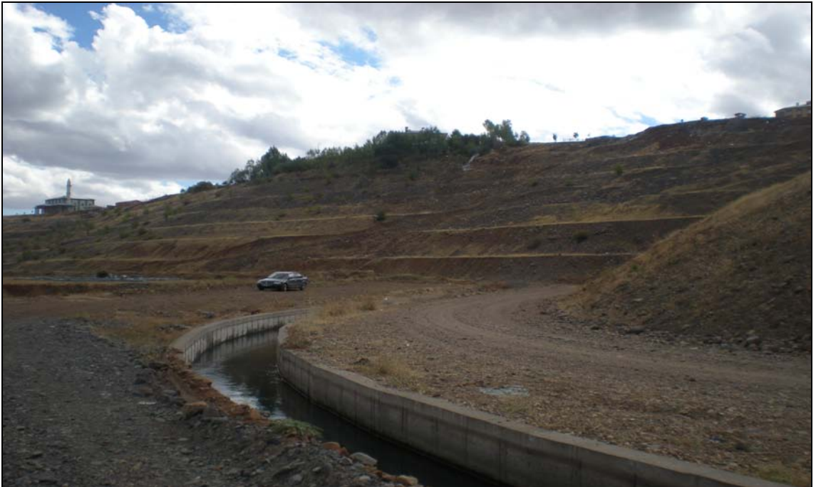
Foto 55.- DSİ tarafından 1993 yılında Gayt çayının güney yamacında kanalet ve yol çalışması yapılmış, bu süreçte yamaçta kütle hareketlerini önleme amaçlı sekileme uygulaması zemine applike edilmiştir.
