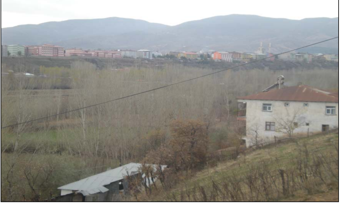
Foto 20.- Çapakçur Çayı vadisi yamaçlarında bulunan konutlar (güneyden görünüm)
