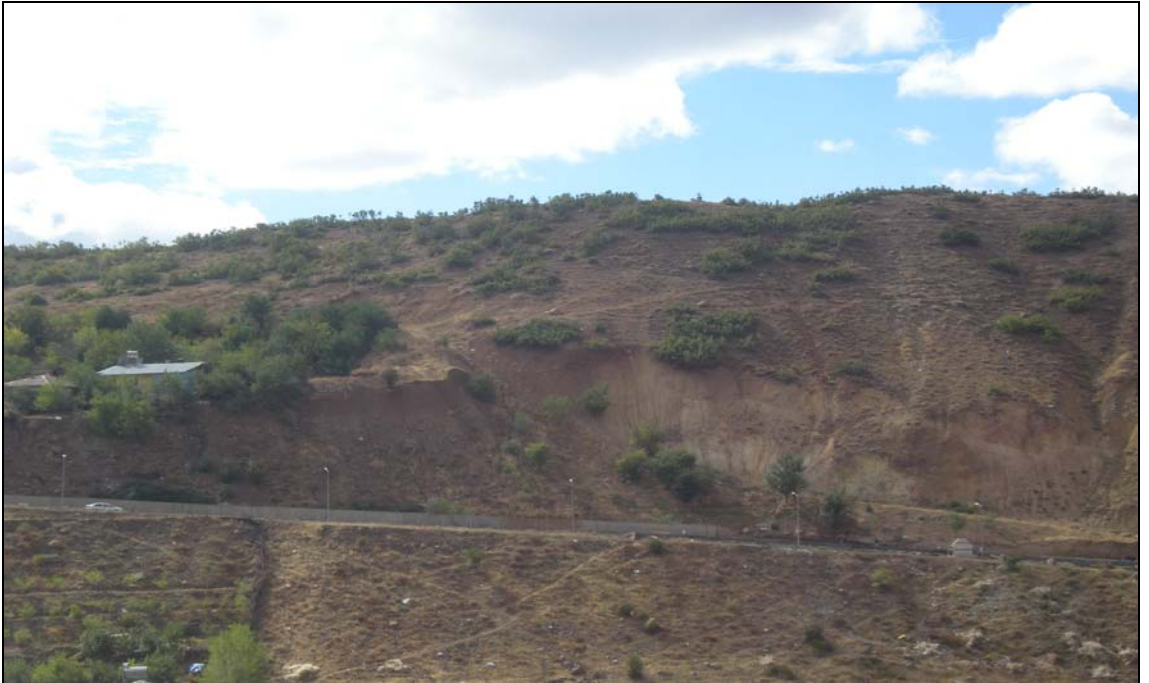
Foto 59.- Çapakçur çayı vadisinin güney yamaçlarında kumlu toprak yapısı, bitki örtüsü varlığı ve mevcut drenaj sistemi heyelan tehlikesini azaltmakta ancak kaya düşmeleri tehlikesi devam etmektedir (Bahçelievler Mahallesi)
