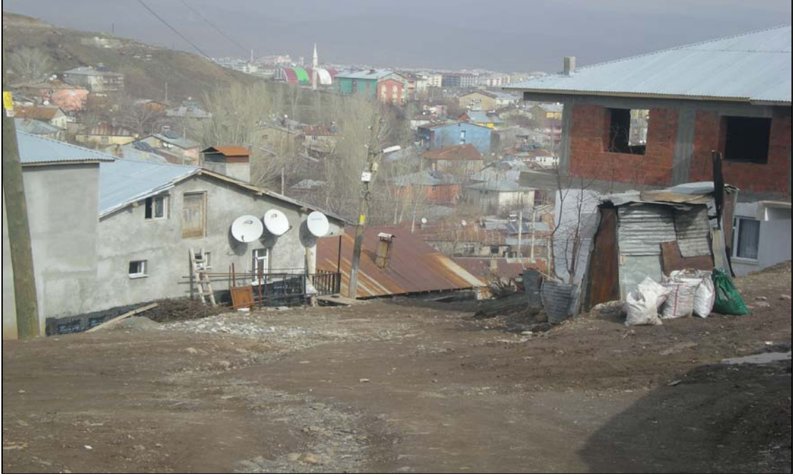
Foto 64.- Islah edilmemiş dereler, kanalizasyon eksiklikleri, asfaltlanmamış şehir içi yollar ve arazinin topografyası, yağış olaylarının felakete dönüşmesine neden olmaktadır(Mirzan Mah.).
