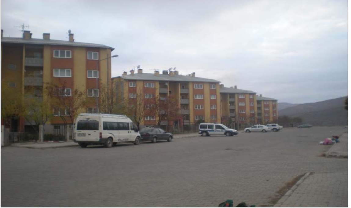
Foto 29.- Son yıllarda yoğun olarak yapılaşmaya açılan Uydukent Mahallesinde çağdaş, betonarme tipi çok katlı binalar bulunmaktadır.
