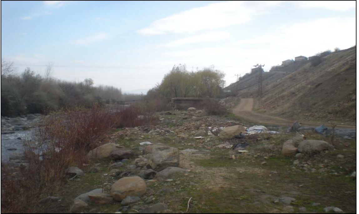
Foto 21.- Geçmişte ve günümüze yamaçlardan yuvarlanan kayalar, yapılar için ciddi tehdit oluşturmaktadır (Bahçelievler Mahallesi)
