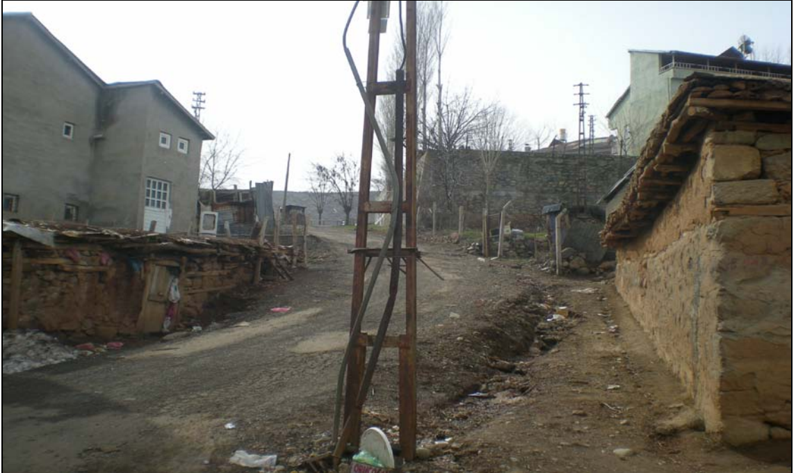
Foto 63.- Kentsel altyapı eksikliklerinin yaşandığı bazı mahallelerde özellikle yağışların yoğun olarak yaşandığı kış ve ilkbahar aylarında mevsimsel taşkın, sel gibi olaylarla sık karşılaşılmaktadır (Yeni Mah.)
