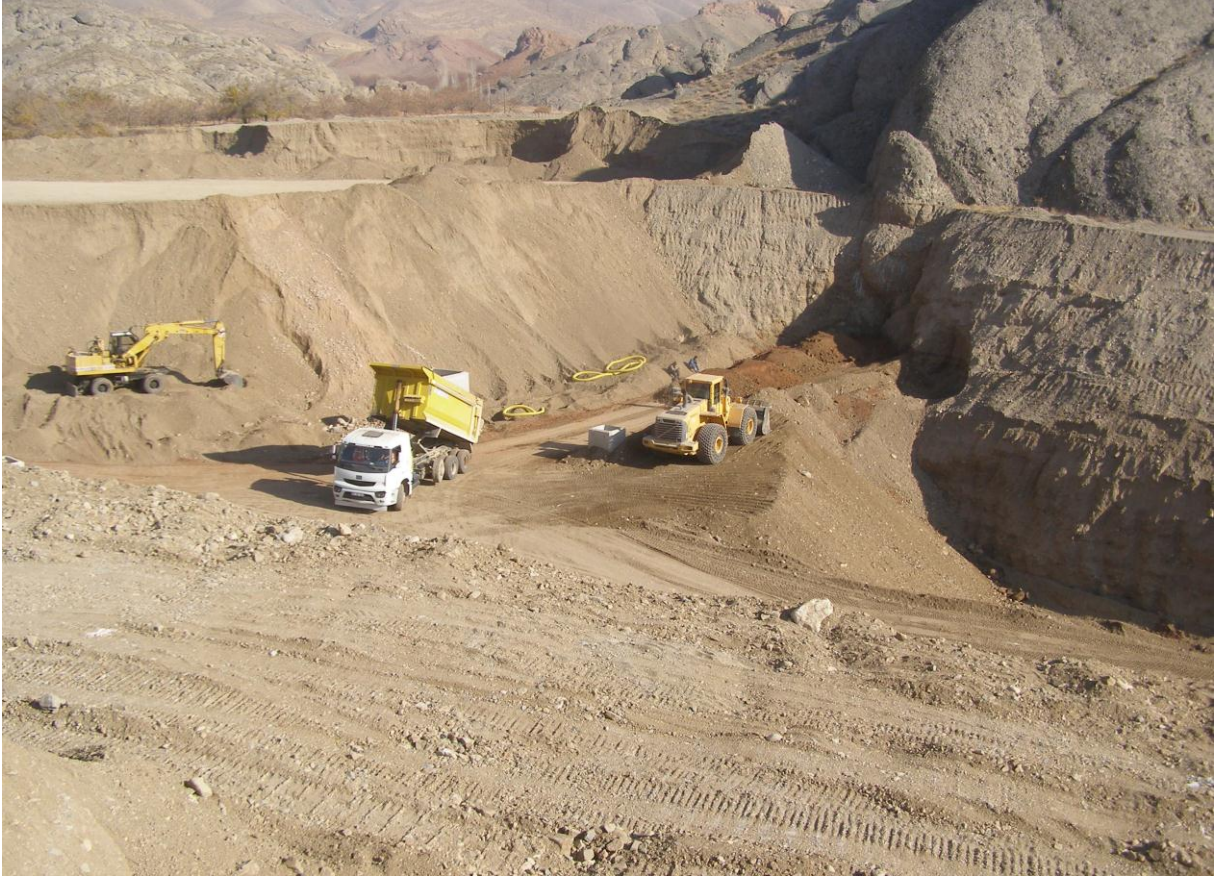
Foto 1: Hardi çayında inşaa edilen yeraltı barajı inşaatından bir görünüm, ( Kara yolunun 500 m K'i Bakış KD'ya).
