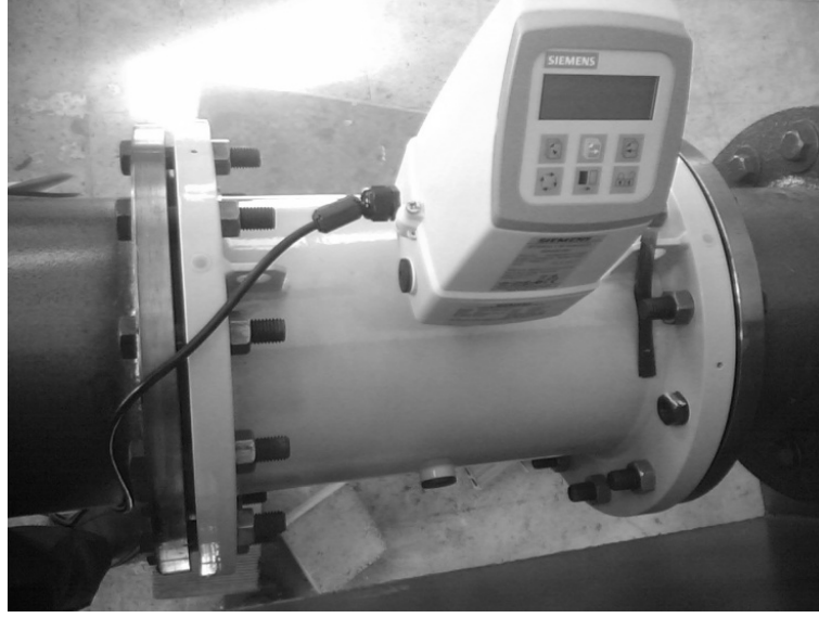
Şekil 3.4. Giriş debisini ölçen elektromanyetik debimetre
