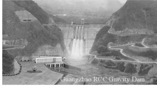
Şekil 2.1. Guangzhao Barajından bir görünüm
