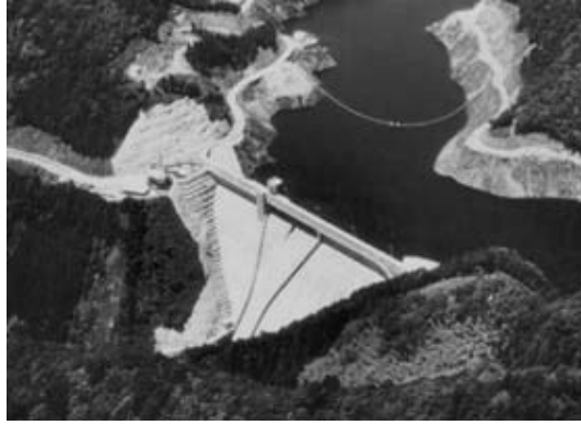
Şekil 2.2. Shimajigawa Barajından bir görünüm
