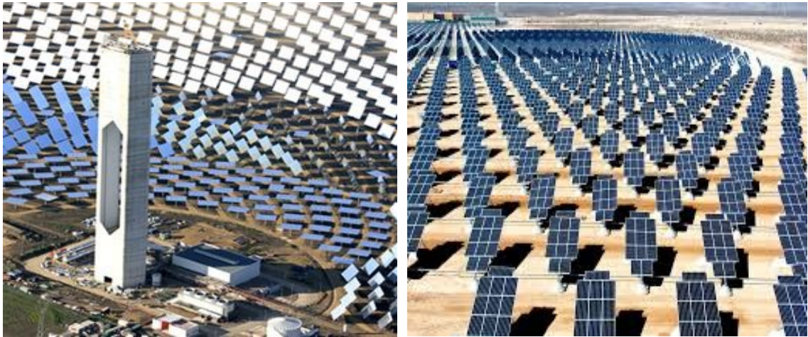
Şekil 3. 1. Güneş enerjisinden elektrik üretiminde dolaylı yöntem ve doğrudan yöntem kullanımı
