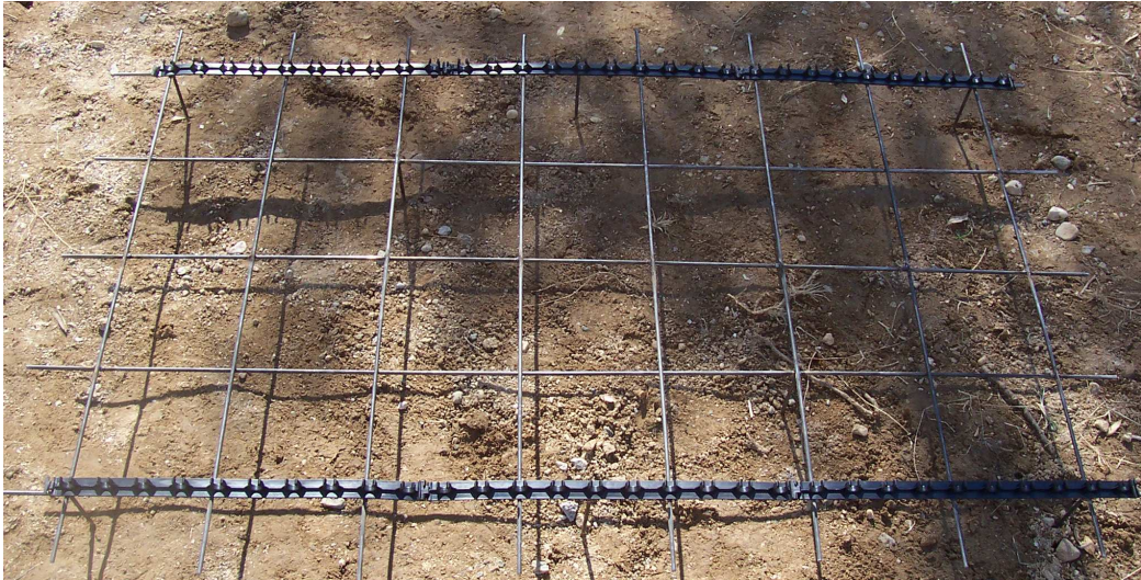
Şekil 3.12 Köprü ve yer modeli için demir donatının görünümü
