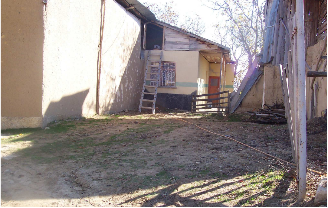
Şekil 3.1 Kuyu açılacak alanın görünüşü
