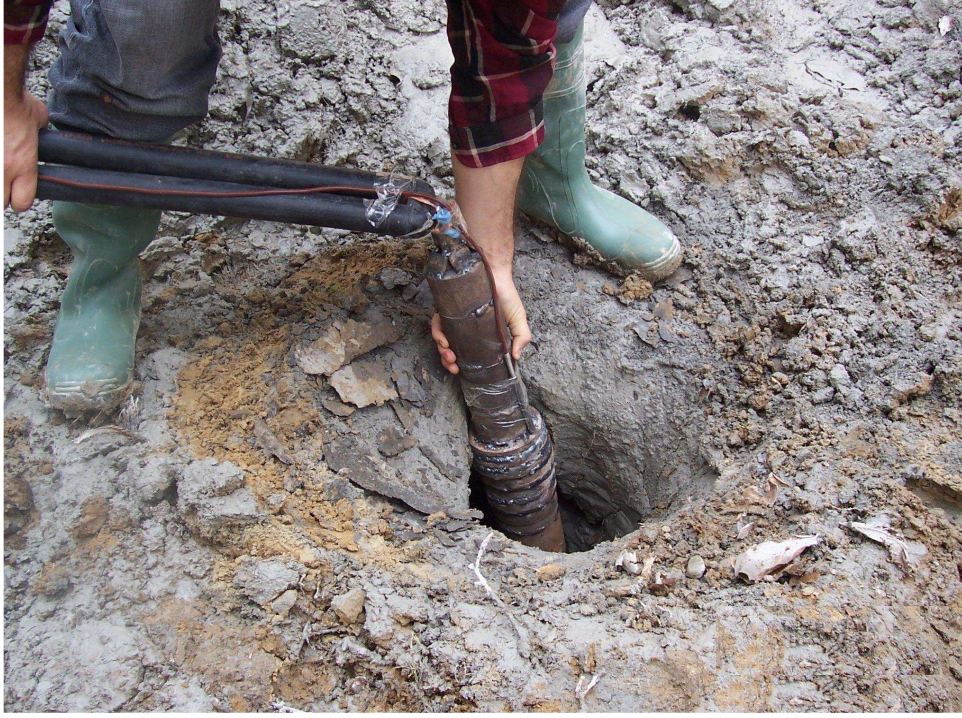
Şekil 3.4 U-borusunun kuyuya yerleştirilmesi
