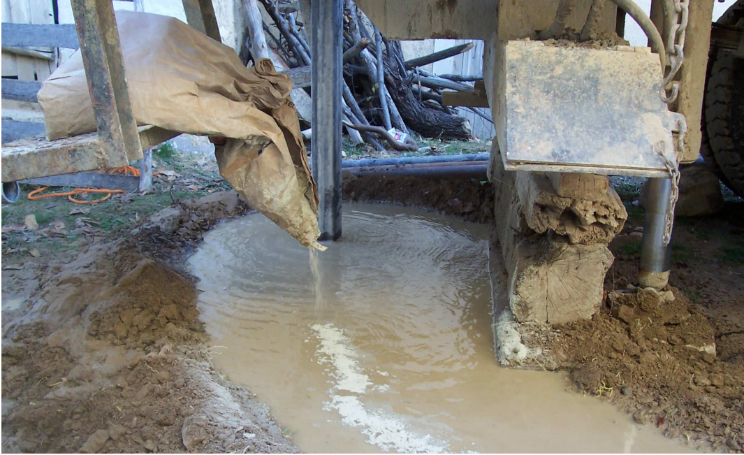
Şekil 3.2 Kuyu açılması sırasında bentonitin aktarılışı
