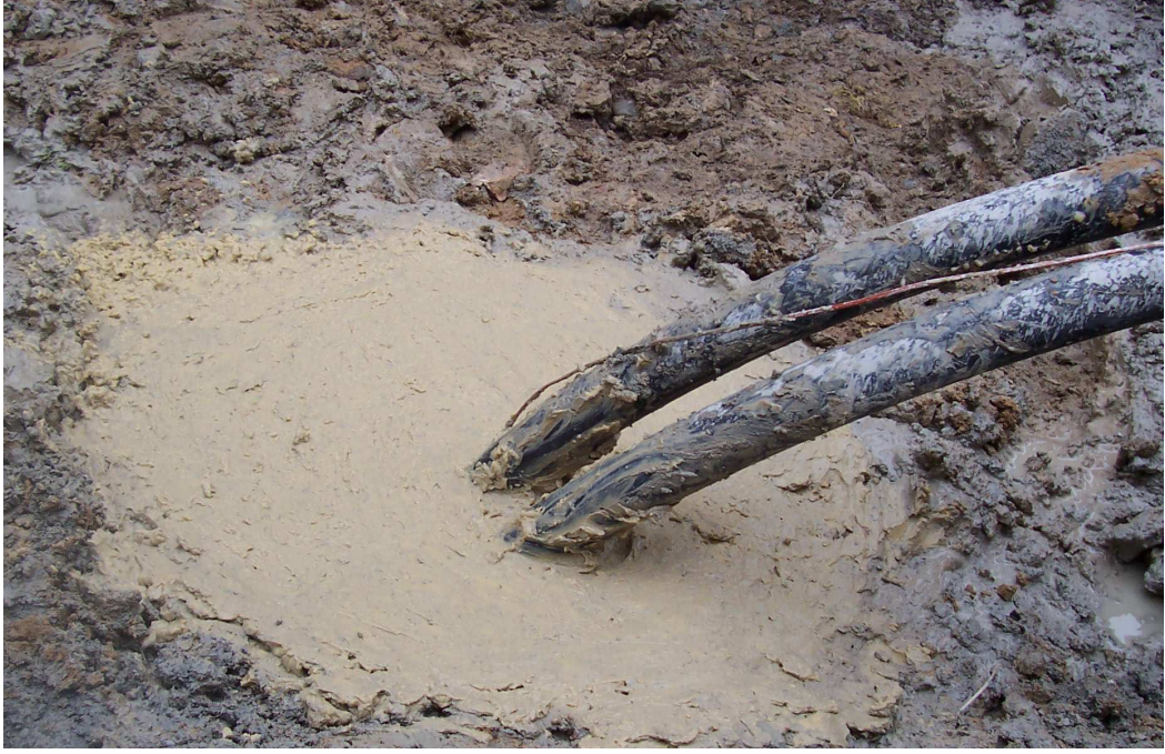
Şekil 3.5 U-borusunun bentonit dolgusu ile dolgu yapılmış halinin görünümü
