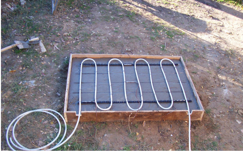
Şekil 3.15 Borulu demir donatının beton bloğa yerleşiminin görünümü
