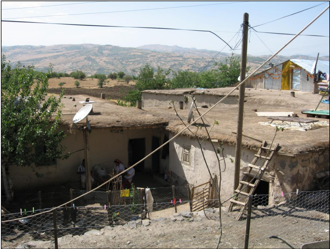
Foto: 3.15. Düz dam kerpiç evler ( Ormancık Köyü)
