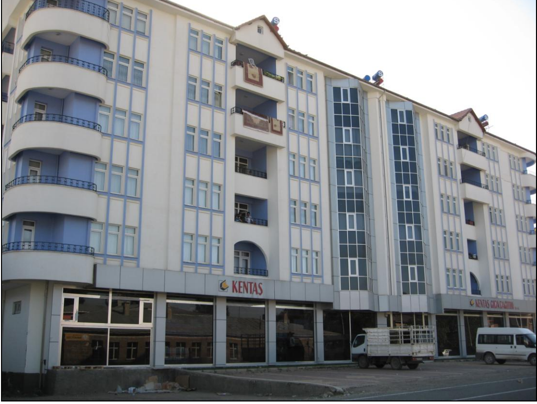
Foto: 3.10. Atatürk Caddesi üzerinde bulunan betonarme binalar: Binaların alt katları genellikle iře yeri olarak planlanmaktadır.
