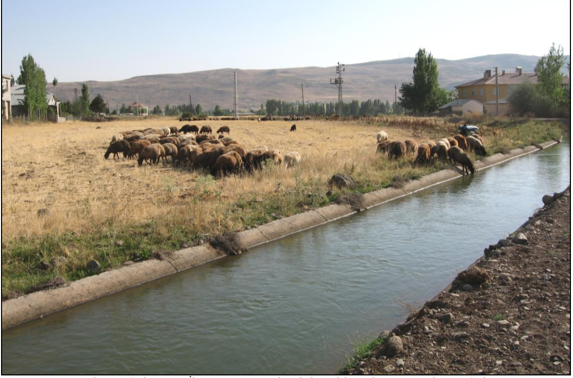
Foto: 3.7. Karakoçan Sulaması: İki ana ve on yedi tali kanaldan oluşan Karakoçan Sulaması kentleşmeden dolayı tarım arazi pek fazla kalmadığı için şehrin içinde akarak zengin bir su varlığı sergilemektedir
