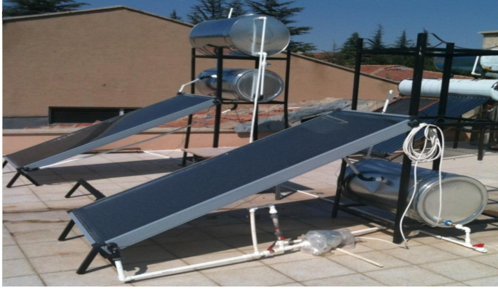
Şekil 2.18. Doğal ve cebri dolaşımli sistem
