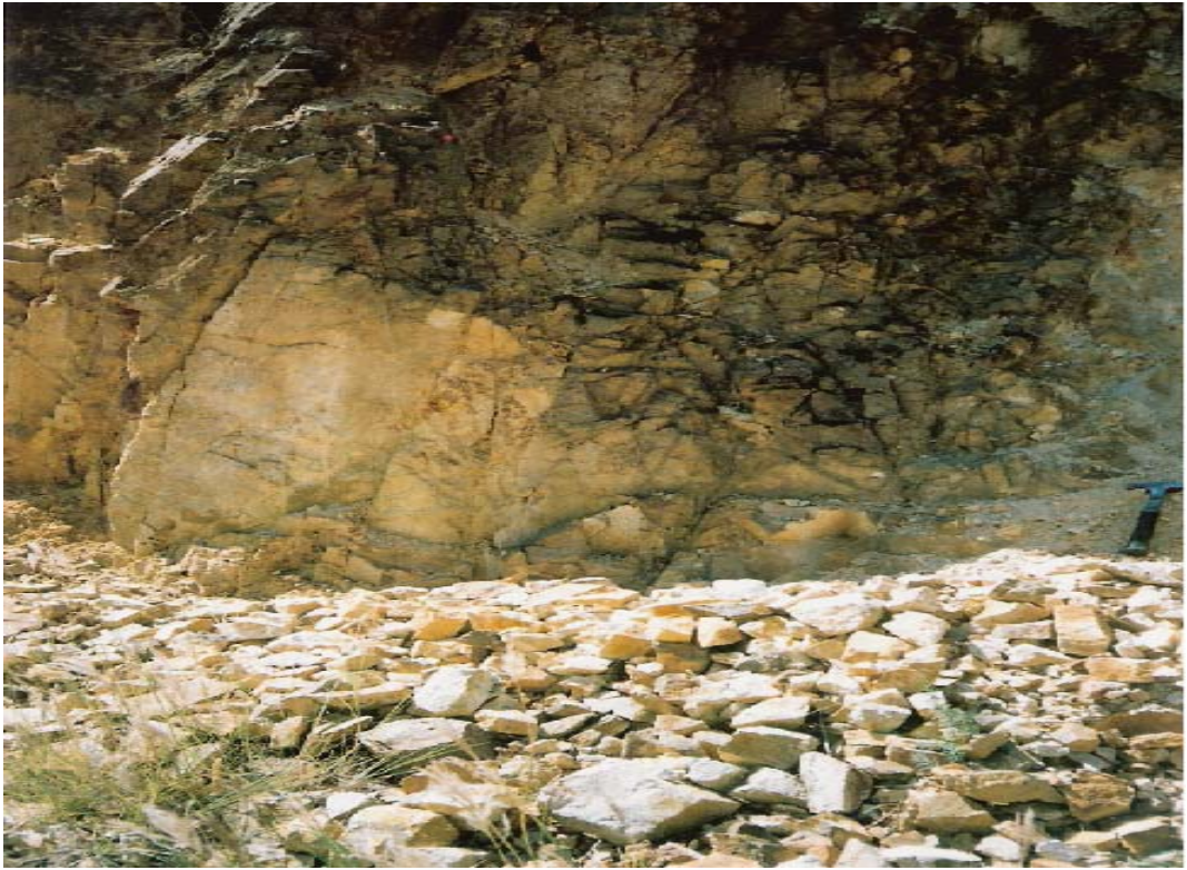
Şekil 5: Magmatik kayalarla ilişkili kırıklı-çatlaklı kuvars damarları. Bakış yönü güney.
