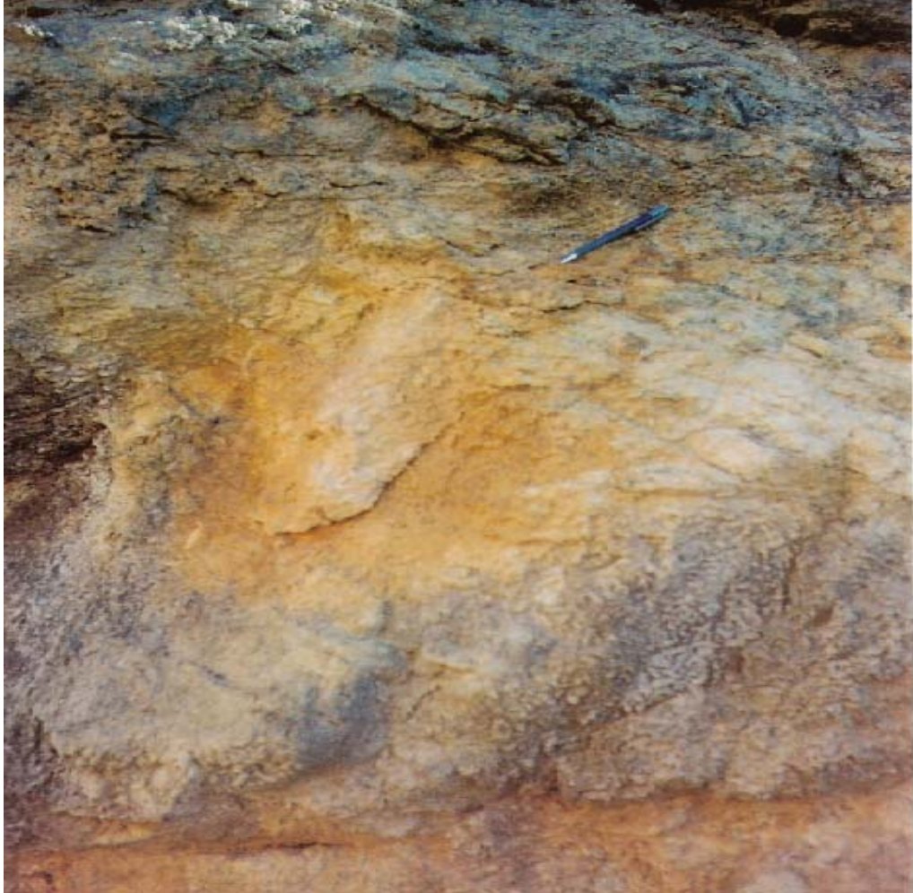
Őekil 28: Arazide gözlenen alterasyonlar. Bakış yönü güney.
