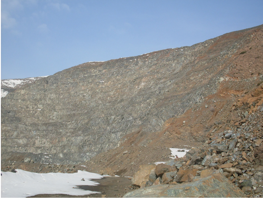
Şekil 5.4. Batı Kef açık işletmesinden bir görünüm
