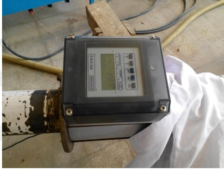
Şekil 5.4 Dijital göstergeli elektromanyetik debimetre fotoğraf görünümü
