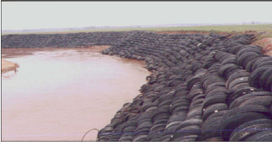
Şekil 4.4. Bütün lastiklerin şev korumasında kullanılması
