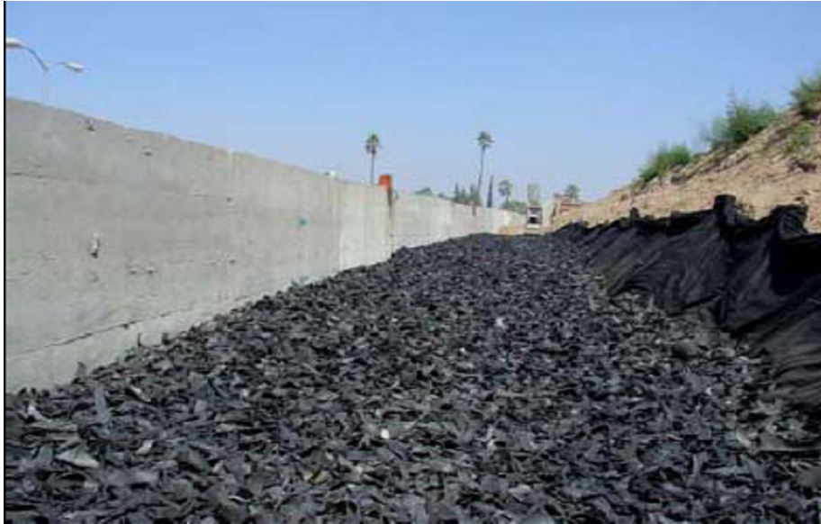
Şekil 4.5. Kullanılmış araç lastiklerinin duvar arkası dolgusunda kullanılması
