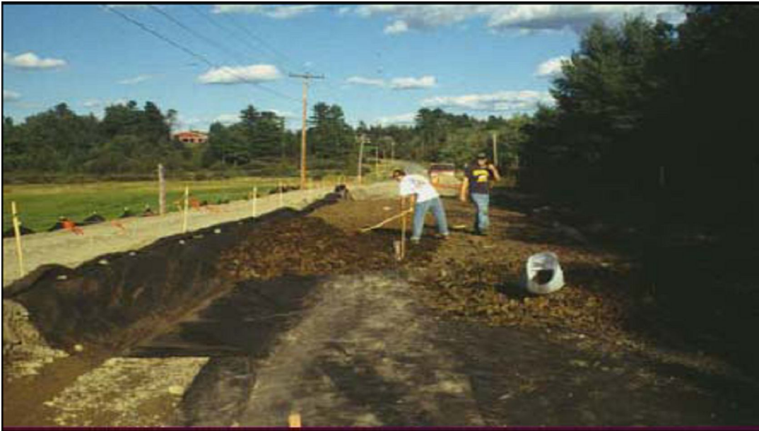
Şekil.4.6. Kullanılmış araç lastiklerinin yol gövdesinde kullanılması [49].
