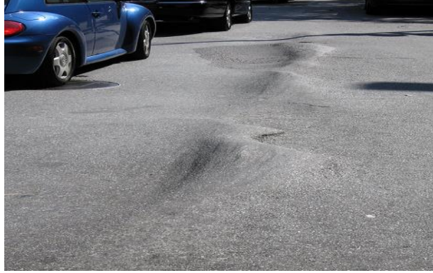
Şekil 4.8. Asfalt betonu kaplama ondülasyonları [171].
