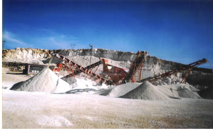
Şekil 6.9. Agregat konkasör şantiyesi
