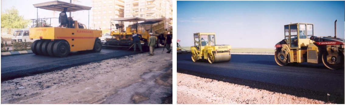
Şekil 2.8. BSK'nın finişerle yola serilmesi ve silindirlerle sıkıştırılması
