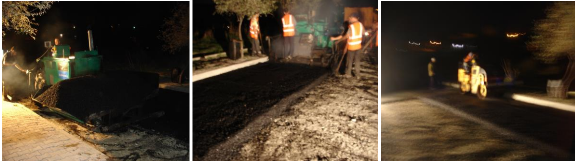
Şekil 7.30. SBS modifiyeli BSK uygulaması
