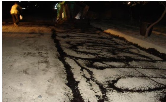
Şekil 7.28. BSK astar uygulaması
