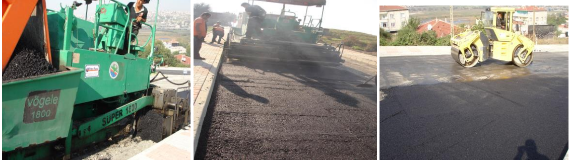
Şekil 7.29. Normal BSK uygulaması
