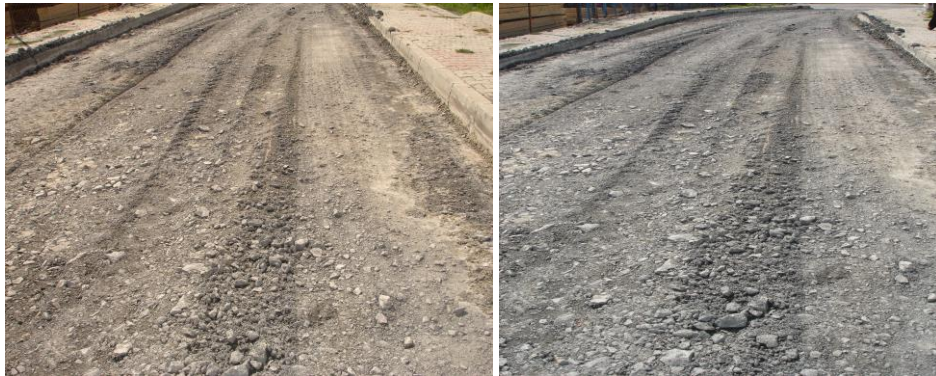
Şekil 7.5. Uygulama sahası yol üst yapısı granüler temel tabakası
