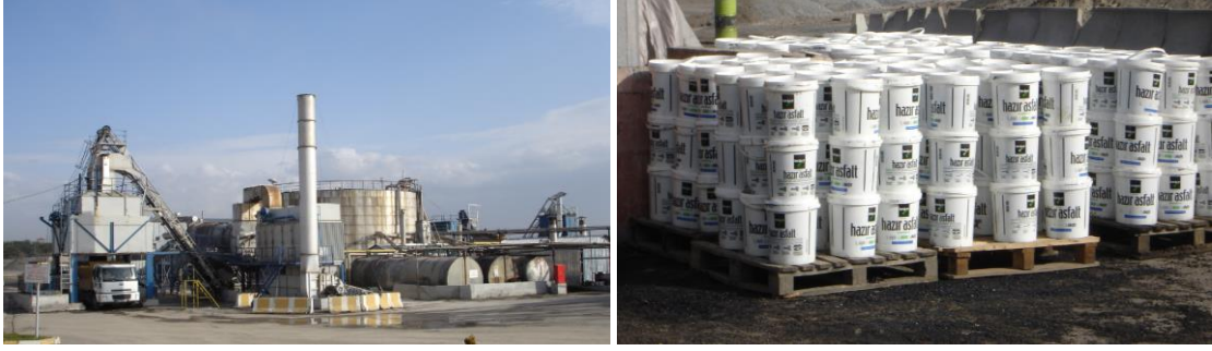
Şekil 7.37. İsfalt plant şantiyesi ve soğuk hazır asfalt stokları
