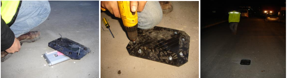
Şekil 7.32. Trafik analiz ölçüm cihazı montajı
