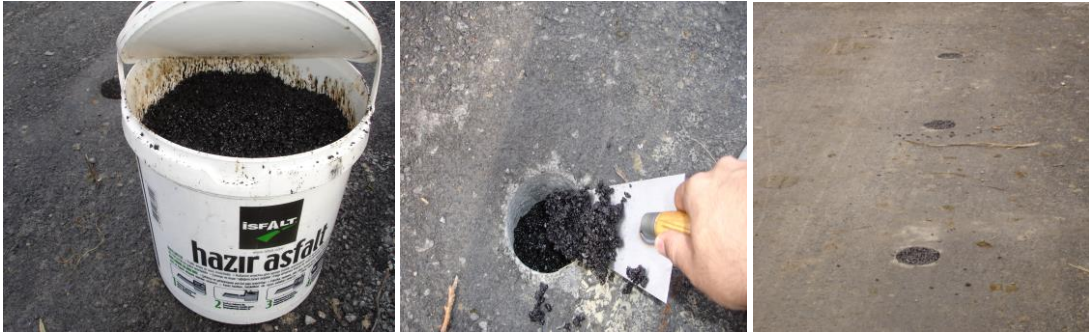
Şekil 7.38. Hazır soğuk asfalt karışımla karot boşluklarının doldurulması
