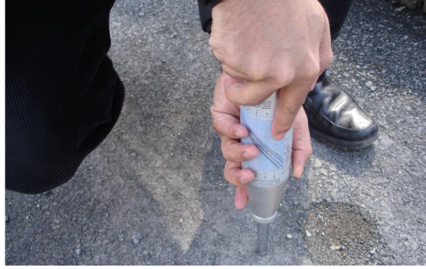
Şekil 7.44. Tekerlek geçiş bölgesi test çekici ölçümleri
