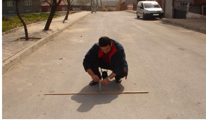
řekil 6.37. Asfalt betonu kaplama tekerlek izi ¼l¼m¼
