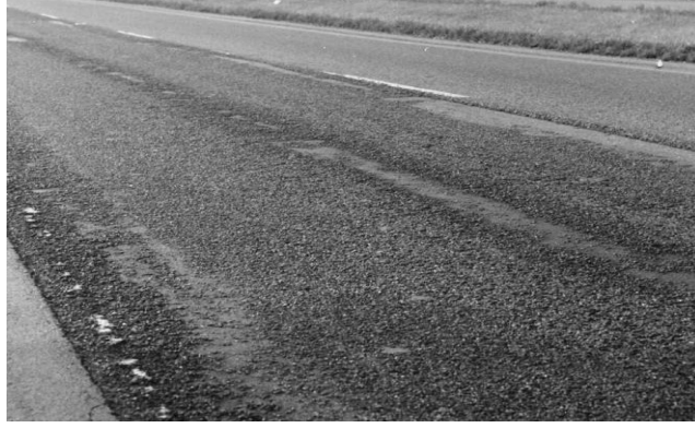
Şekil 4.17. Agregalardaki asfalt filmi soyulması
