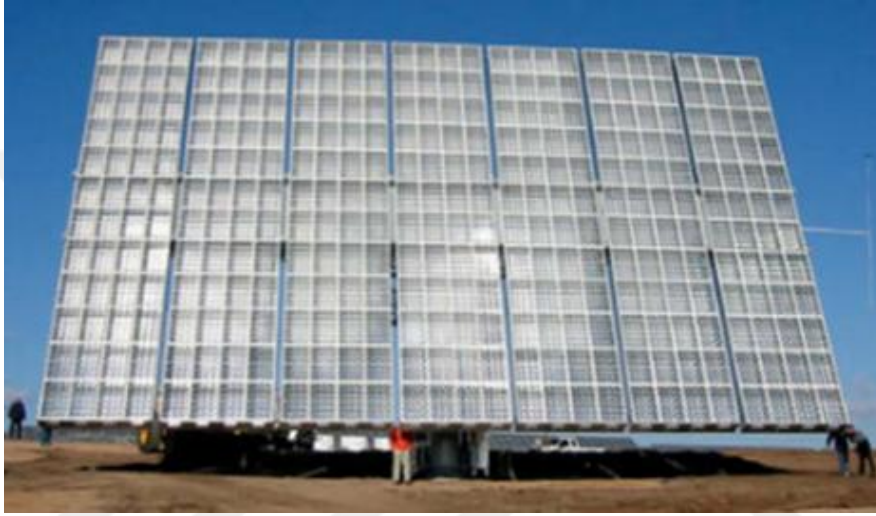
Şekil 1.7. CPV teknolojisiyle hazırlanmış tasarım örneği [37].
