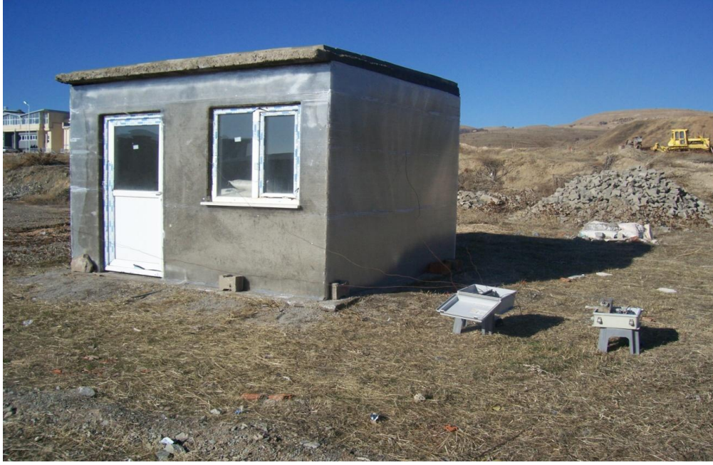
Şekil 2.2. Duvarları FDM ile ısı yalıtımlı test odası ile sıcaklıkları ölçüp kaydeden datalogger (veri kaydedici) ve güneş ışınlamını ölçen solarimetrenin görünüşü.
