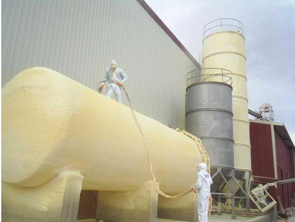
Şekil-5. 5. Poliüretan köpüğün tank yalıtımında kullanılması [33]
