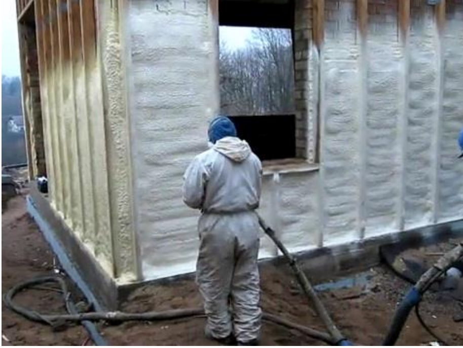
Şekil-5. 1. Poliüretan köpüğün duvar yalıtımı uygulaması [29]
