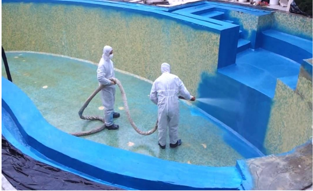
Şekil-5. 3. Poliüretan köpüğün yüzme havuzu uygulaması [31]
