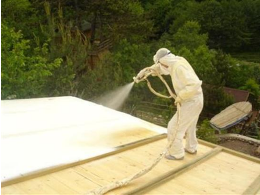
Şekil-5. 2. Poliüretan köpüğün çatı yalıtımı uygulaması [30]
