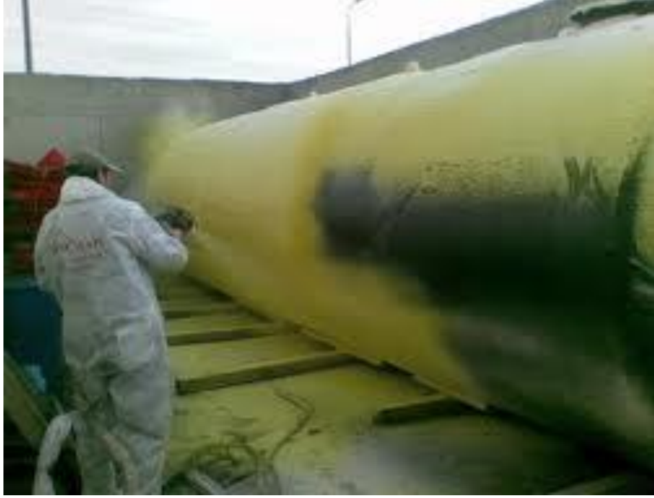
Şekil-5. 6. Poliüretan köpüğün boru yalıtımında kullanılması [34]
