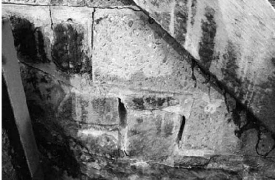
Şekil 4.3. Liman duvar basamaklarının genel görünümü [54]
