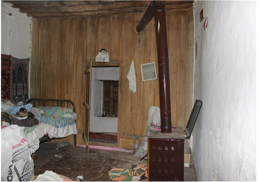
Foto 20. 21 - Birinci Kat Oda Batı Cephe
