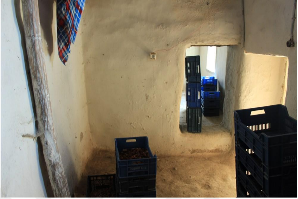
Foto 36. 13 - Zemin Kat Oda Güney Cephe
