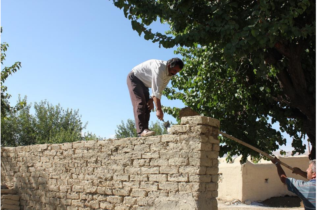
Foto 59 - Kerpiç Duvar Örne İşlemi
