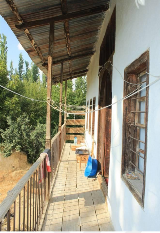
Foto 15. 33 - Hayat Kuzey Cephe
