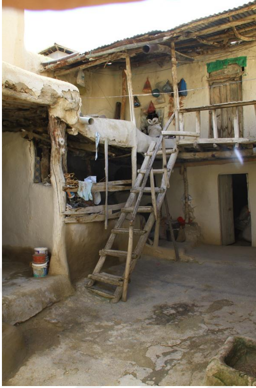
Foto 37. 4 - Avlu Güney Cephe
