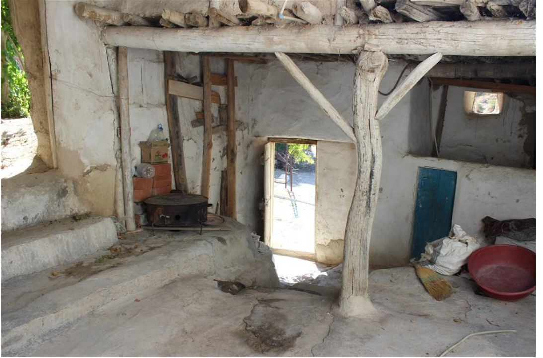
Foto 33. 6 - Avlu Kuzey Cephe
