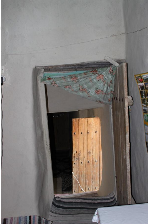
Foto 26. 26 - Ara Kata Açılan Kapı
