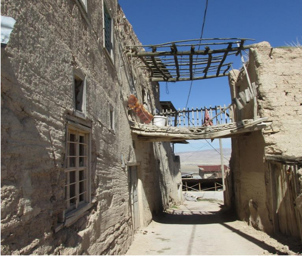
Foto 68 - Balaban Sokak Dokusu ve Ahşap Köprü
