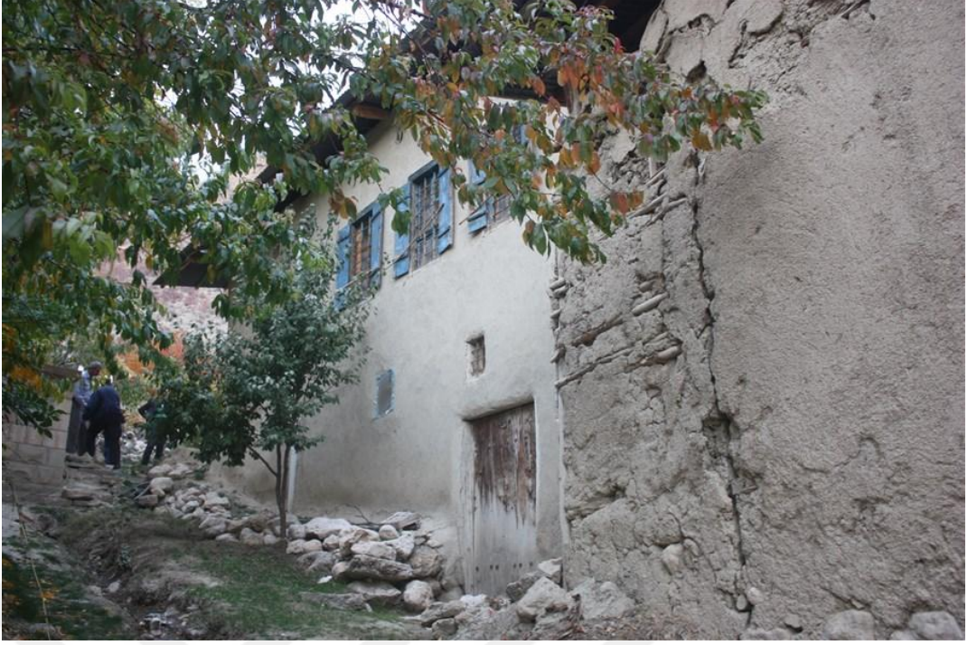
Foto 26. 3 - Tahir Baykal Evi Kuzey Cephe
