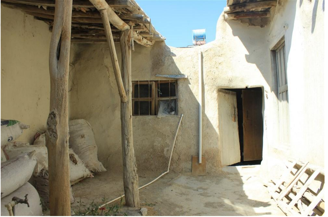
Foto 36. 7 - Avlu Kuzey Cephe
