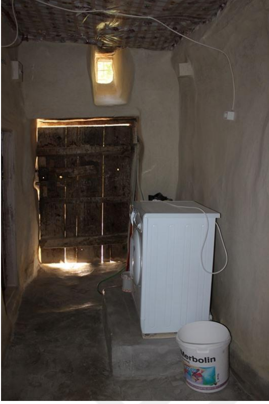
Foto 26. 10 - Zemin Kat Aralık
