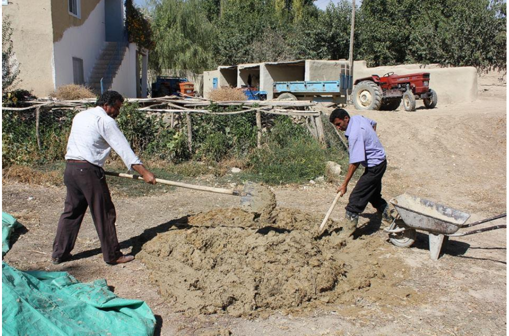
Foto 55 - Kerpiç Çamurunun Hazırlanması (İ. Alaattin ATEŞ Arşivi)
