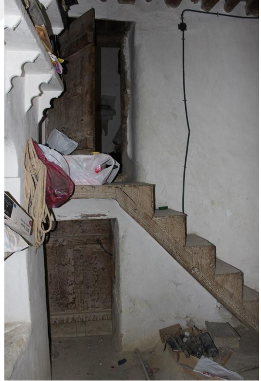
Foto 21. 22 - Zemin ve Birinci Kata Geçiş
