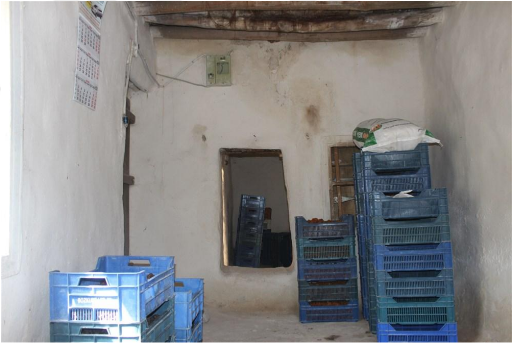
Foto 36. 17 - Zemin Kat Oda Kuzey Cephe
