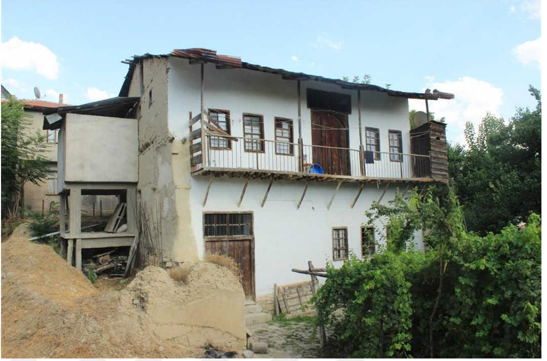
Foto 15. 3 - Hacı Ali Sungur Evi Batı Cephe
