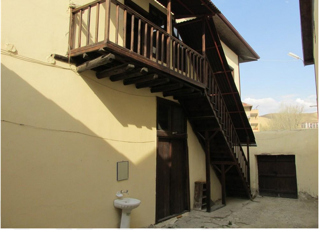
Foto 9. 9 - Avlu Kuzeydoğu Cephe
