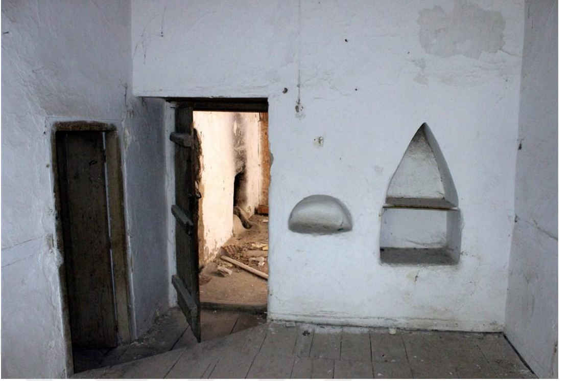
Foto 14. 10 - Zemin Kat Oda Doğu Cephe
