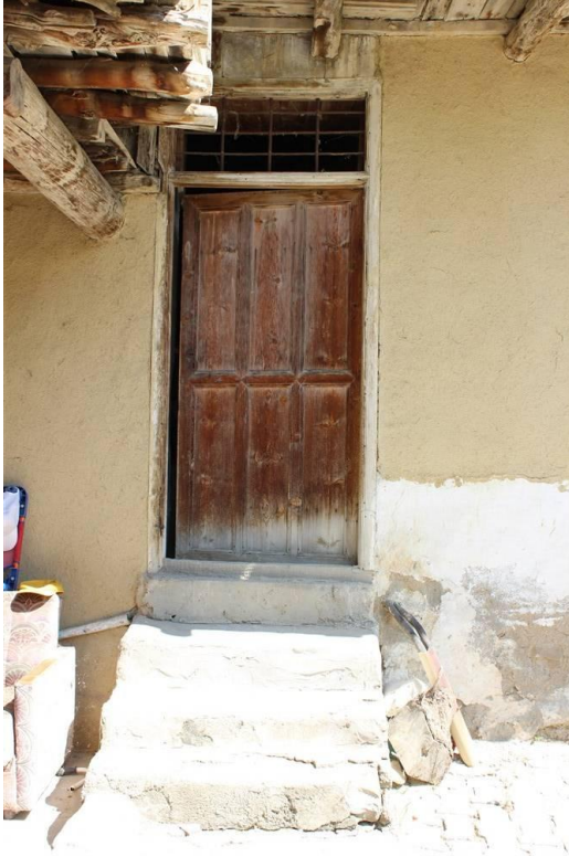
Foto 16. 6 - Zemin Kat Kuzeybatı Cephe Giriş Kapısı
