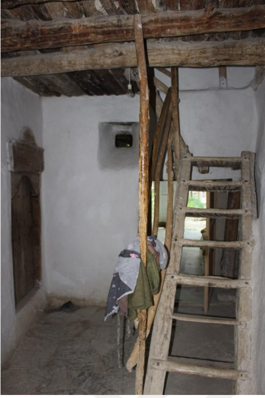
Foto. 25. 9 - Zemin Kat Aralık
