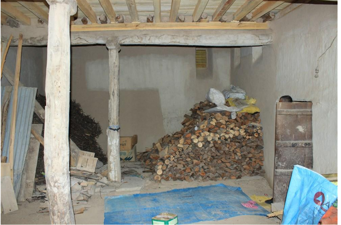
Foto 31. 8 - Zemin Kat Ahır/Depo Güney Cephe
