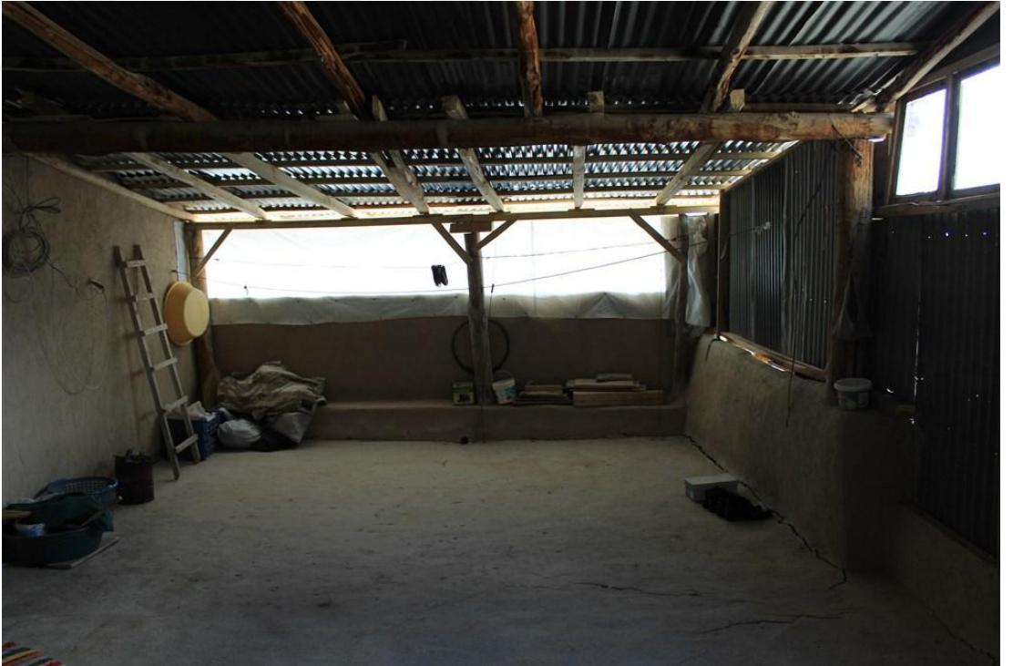
Foto 31. 21 - Yarı Açık Dam Mekânı Kuzey Cephe
