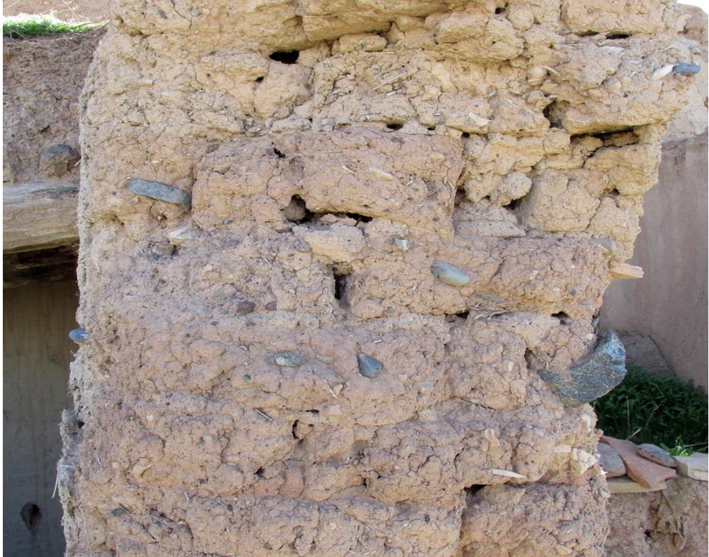
Foto 64 - Kerpiç Harç İçerisinde Taş Parçaları
