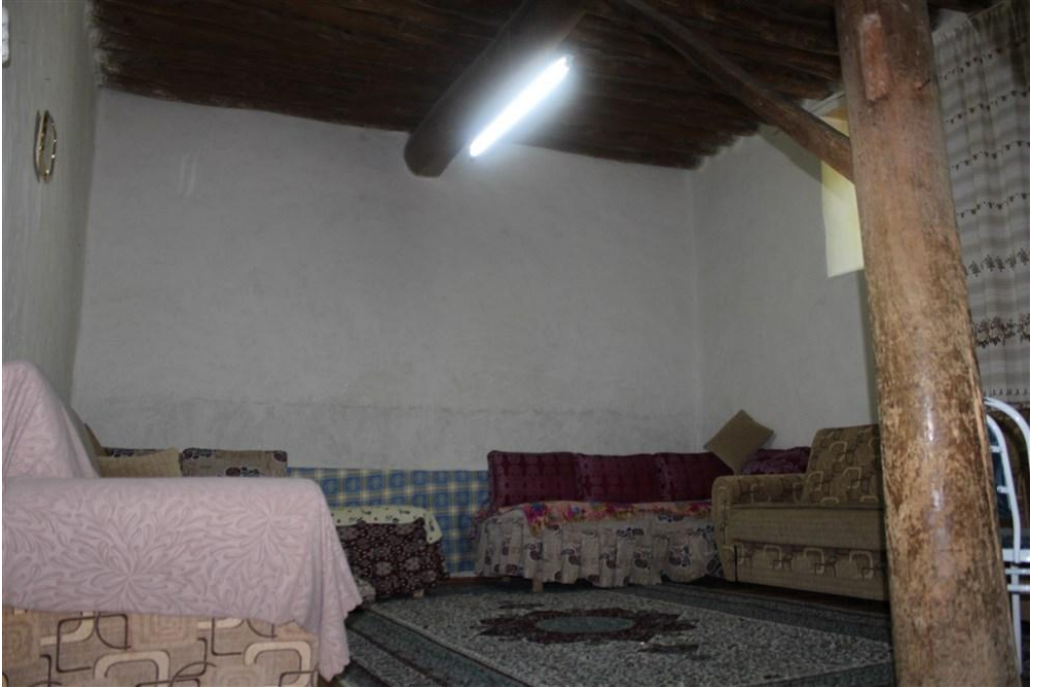
Foto 24. 16 - Zemin Kat Oda Kuzey Cephe
