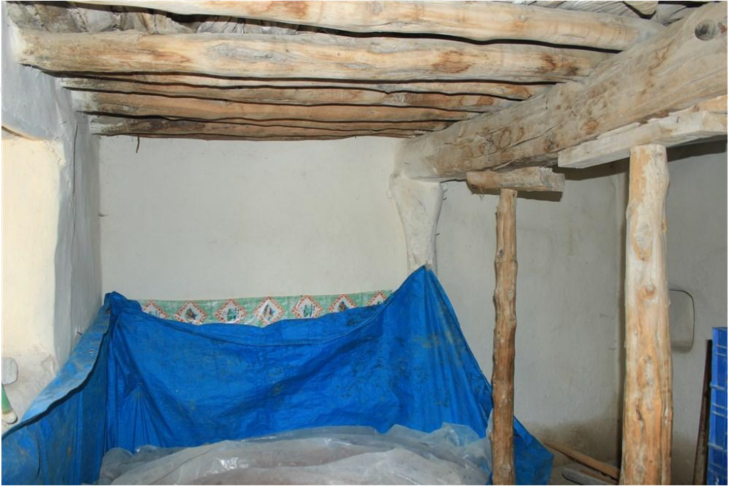
Foto 36. 12 - Zemin Kat Oda Kuzey Cephe
