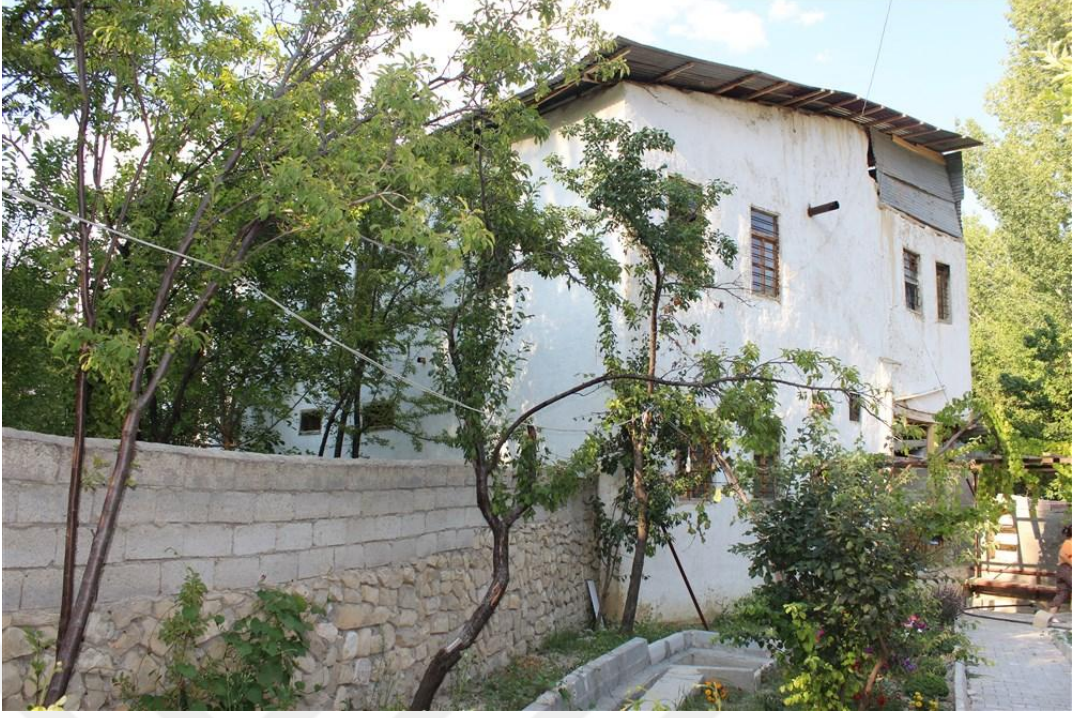
Foto 23. 3 - Hacı Kıvanç Evi Kuzey Cephe
