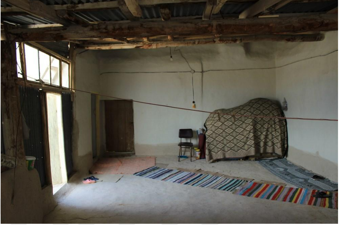
Foto 31. 22 - Yarı Açık Dam Mekânı Güney Cephe
