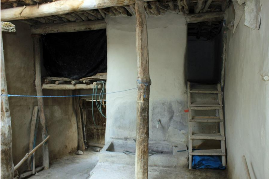
Foto 28. 24 - Avlu Güney Cephe
