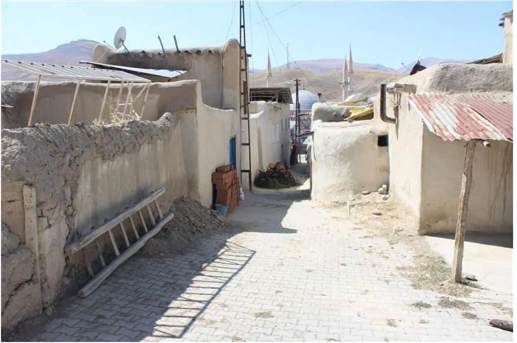
Foto 35. 6 - Erdem Sokak Evleri Doğu Cephe
