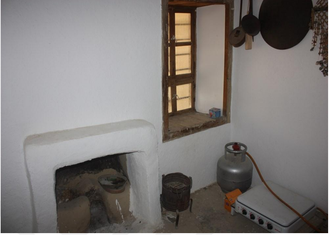
Foto 13. 21 - Mutfak ve Kerpiç Ocağı
