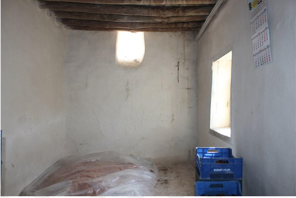
Foto 36. 16 - Zemin Kat Oda Güney Cephe
