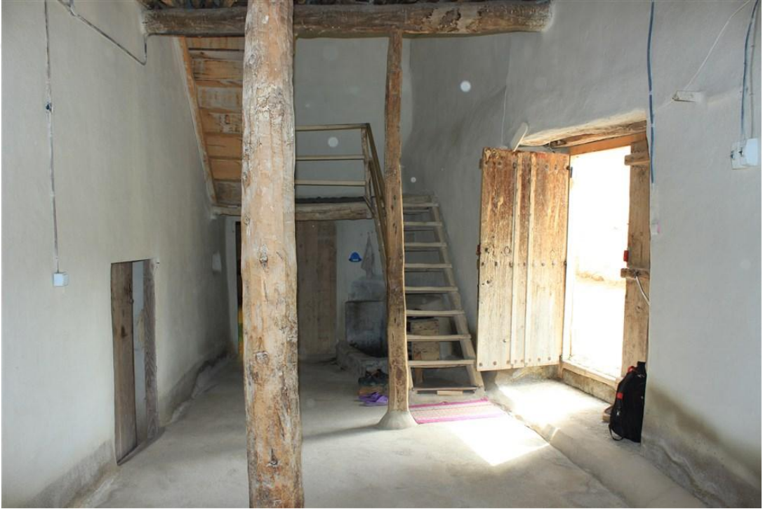
Foto 31. 6 - Zemin Kat Aralık Güney Cephe
