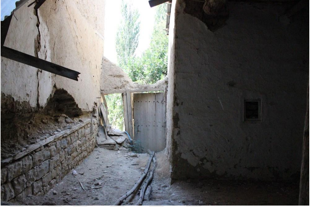
Foto 14. 8 - Avlu Batı Cephe
