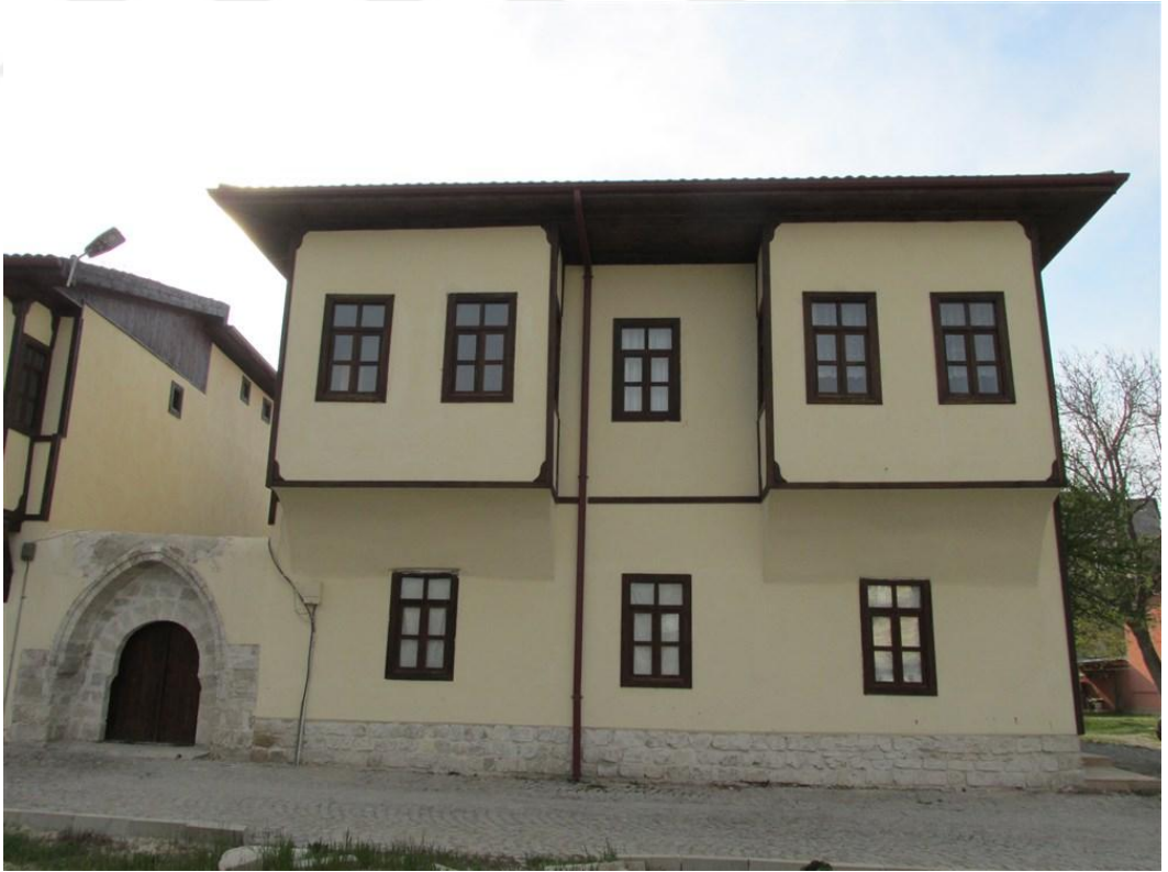
Foto 9. 6 - Abdulvahap Sönmezler Evi Doğu Cephe
