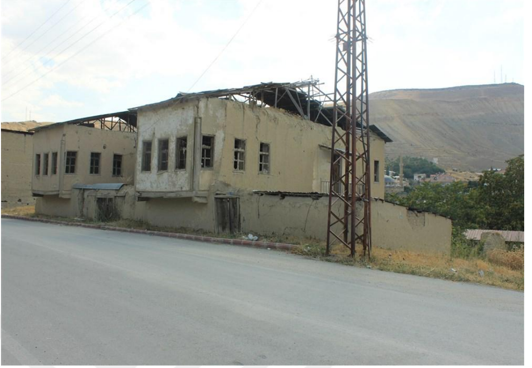
Foto 17. 3 - Yücel Soylu Evi ve Komşu Yapı Kuzeydoğu Cephe
