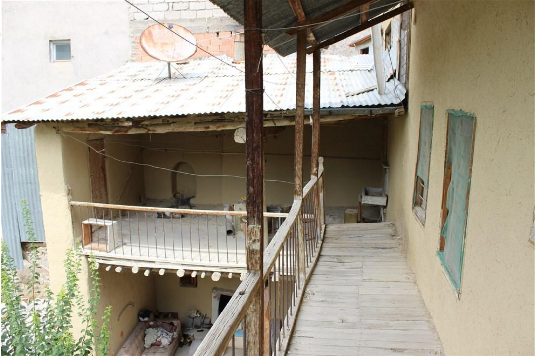
Foto 16. 33 - Hayat Kuzey Cephe
