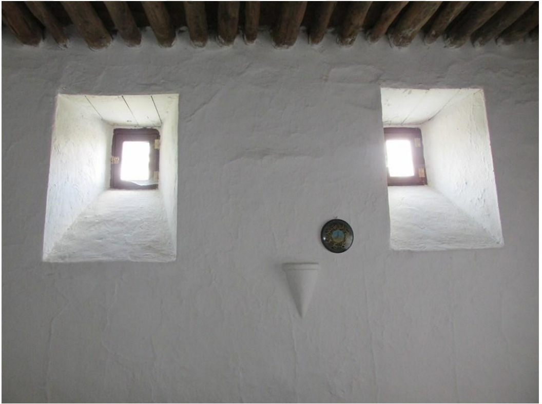
Foto 9. 24 - Şevli Pencere ve Kandillik
