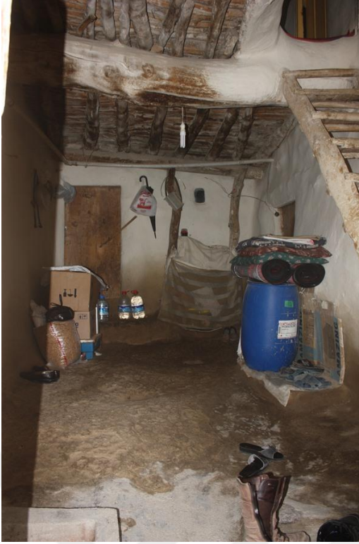
Foto 34. 7 - Aralık Kuzey Cephe
