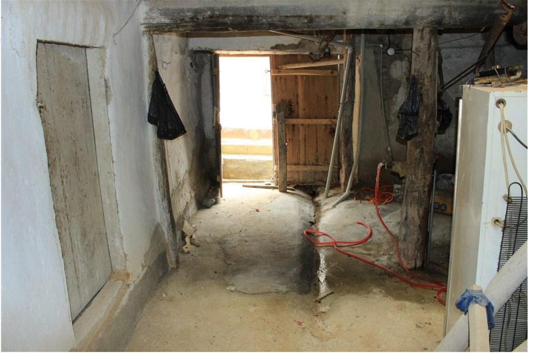
Foto 30. 8 - Zemin Kat Aralık Batı Cephe
