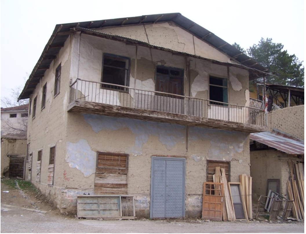
Foto 18. 3 - Ahmet Doğan Evi Batı Cephe
