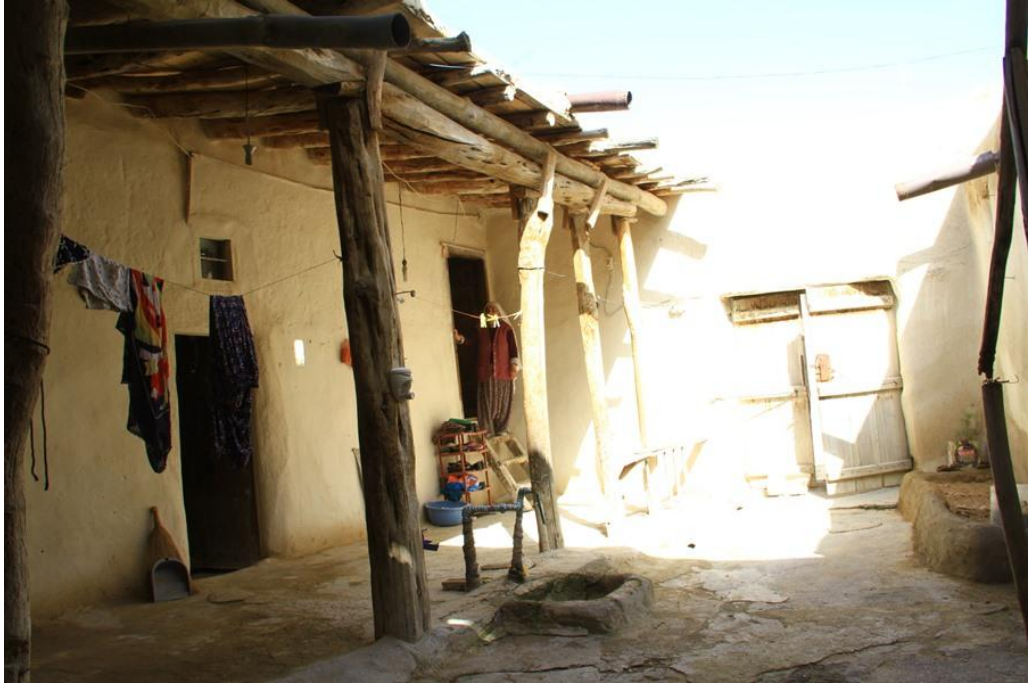
Foto 37. 6 - Avlu Kuzey Cephe
