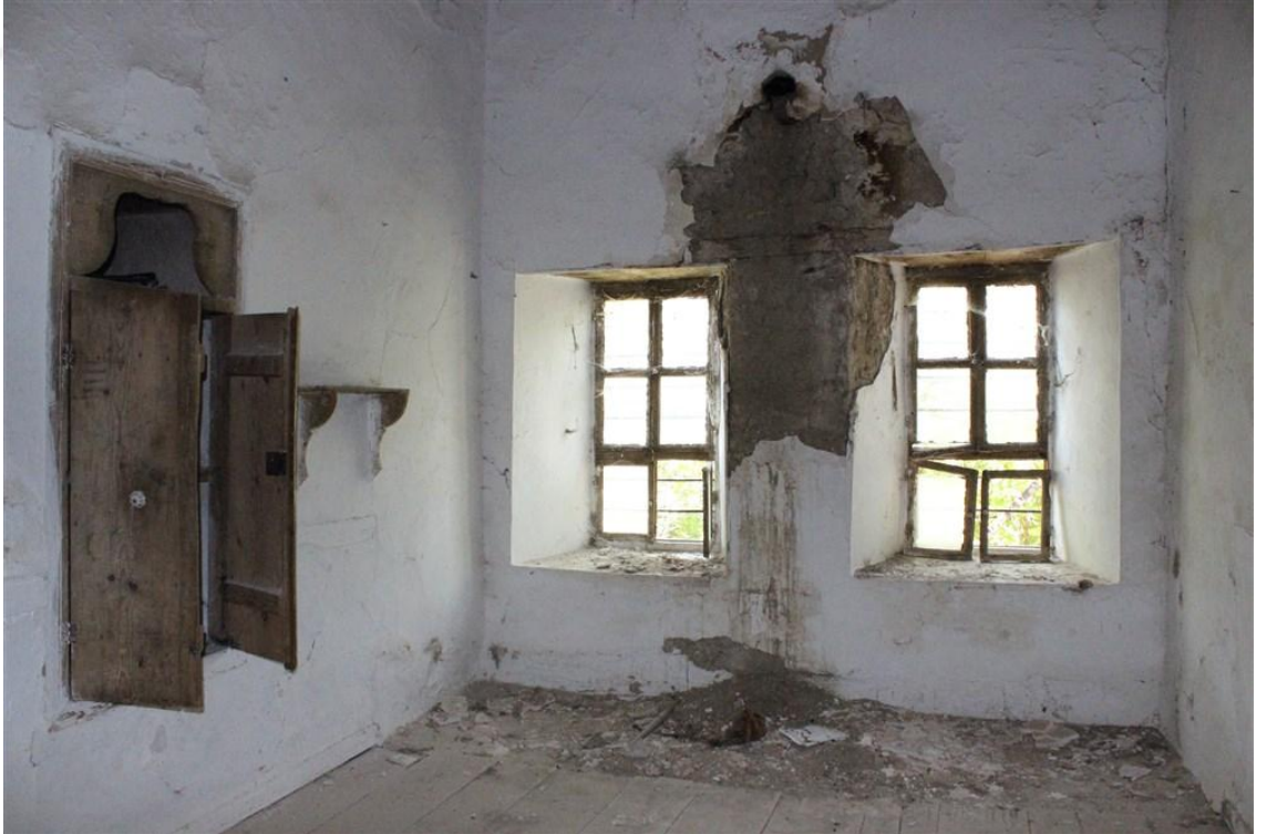
Foto 14. 11 - Zemin Kat Oda Batı Cephe
