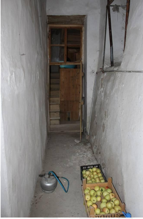
Foto 16. 15 - Zemin Kat Aralık
