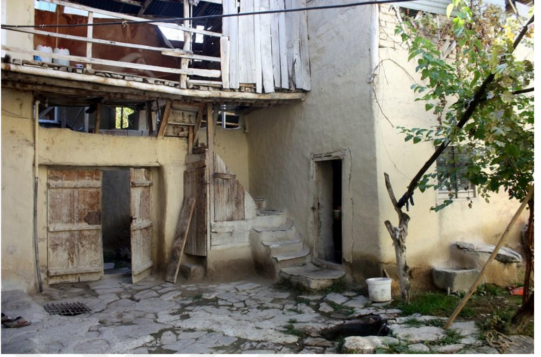
Foto 20. 6 - Avlu Güney Cephe
