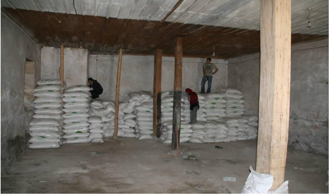
Foto 18. 6 - Zemin Kat Doğu Cephe
