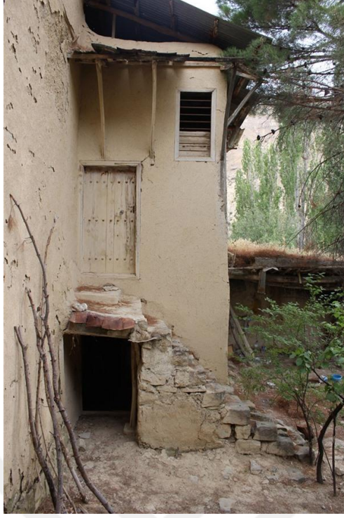
Foto 21. 17 - Avlu Güney Cephe
