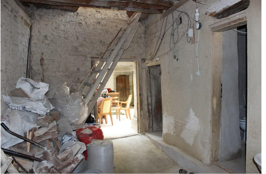
Foto 22. 8 - Zemin Kat Aralık
