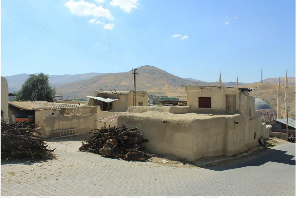
Foto 35. 3 - Erdem Sokak Evleri Kuzey Doğu Cephe
