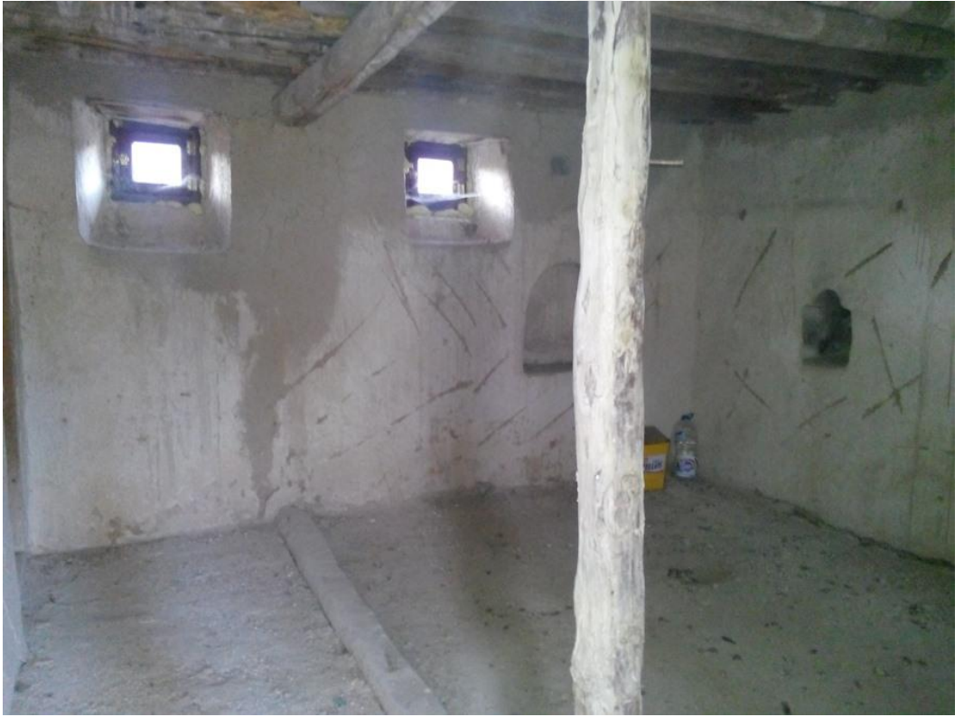
Foto 12. 18 - Birinci Kat Oda Kuzey Cephe
