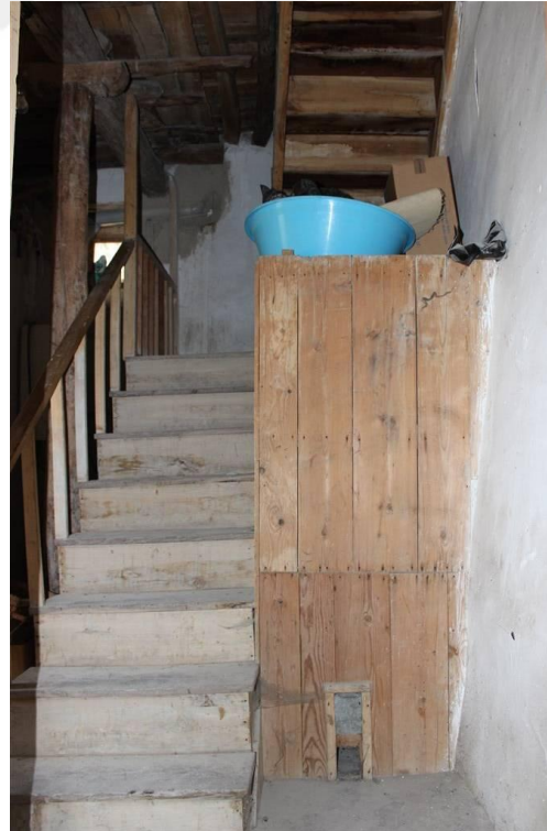
Foto 16. 21 - Ahşap Merdiven ve Ambar
