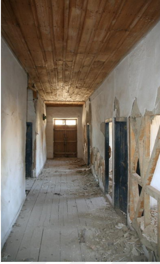
Foto 18. 9 - Sofa Batı Cephe
