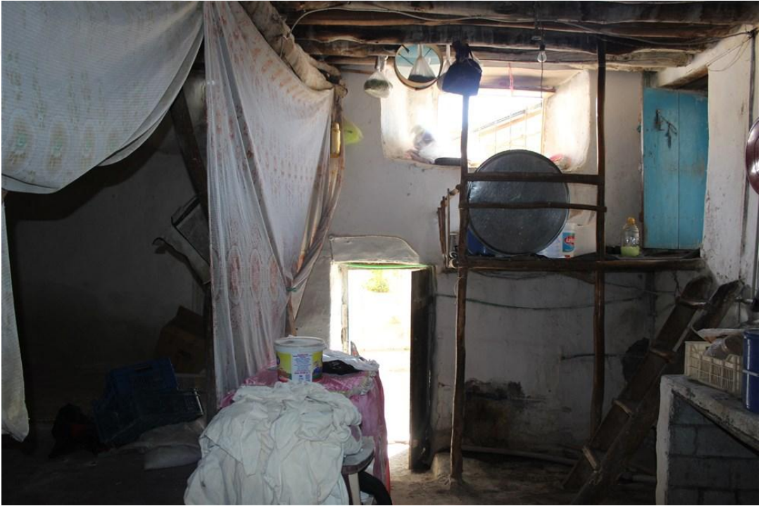
Foto 33. 8 - Zemin Kat Zahirilik Doğu Cephe
