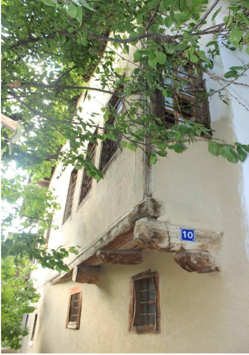
Foto 15. 4 - Güney Cephe Gönye Çıkma
