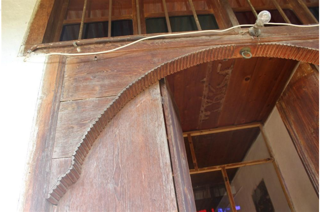
Foto 15. 35 - Kapı Kemerinde Yer Alan Ahşap Üzeri Kesitler
