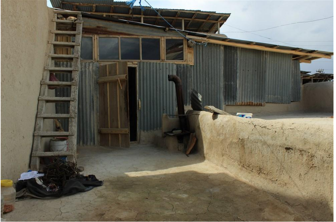
Foto 31. 25 - Toprak Dam Batı Cephe
