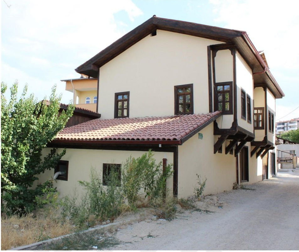
Foto 11. 3 - İhsan Sönmezler Evi Kuzeybatı Cephe
