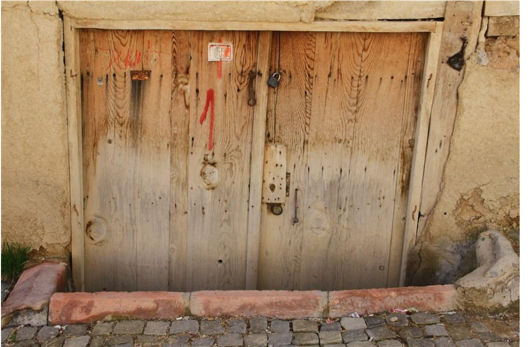
Foto 30. 6 - Zemin Kat Cümle Kapısı
