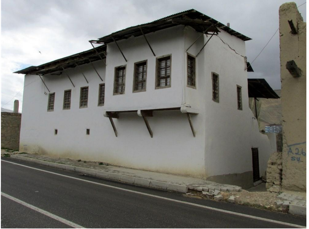
Foto 13. 3 - Kifayet Ocakçı Evi Kuzeydoğu Cephe
