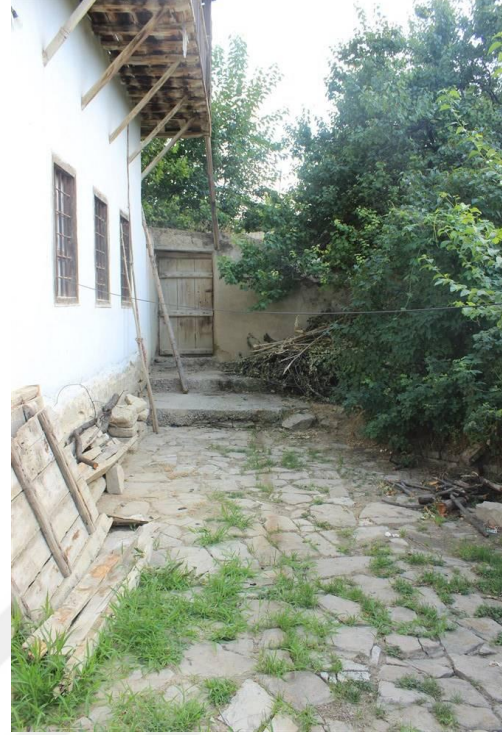
Foto 15. 7 - Taşlık Güney Cephe
