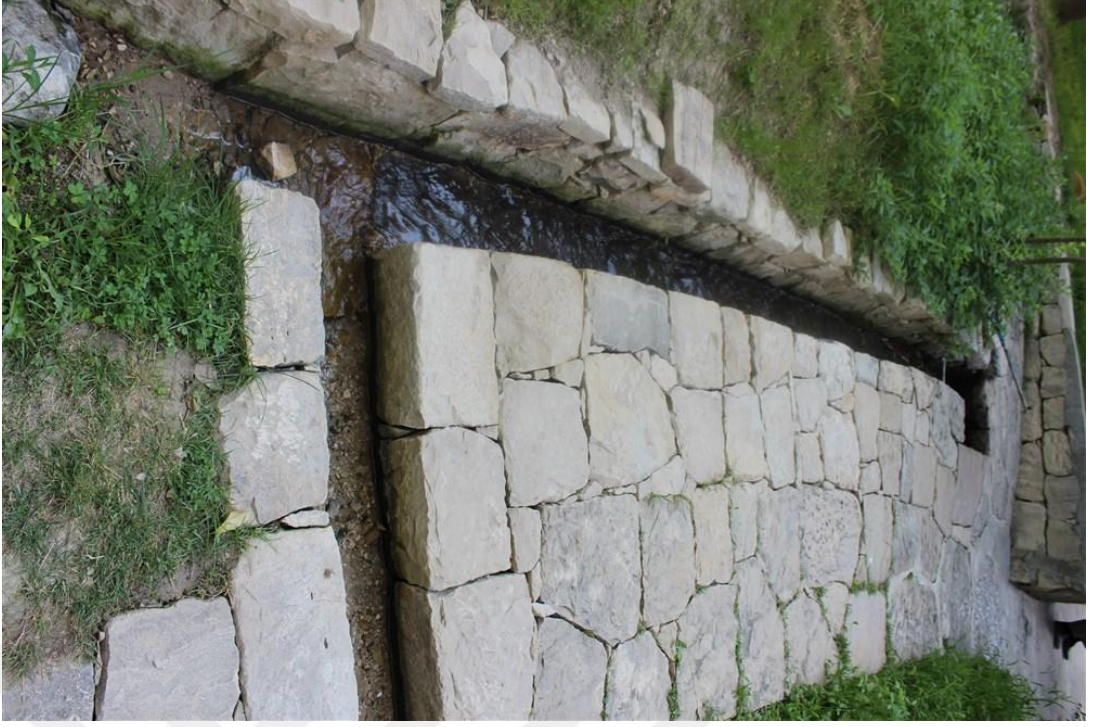
Foto 24. 9 - Bahçe İçerisinde Bulunan Su Kanalı
