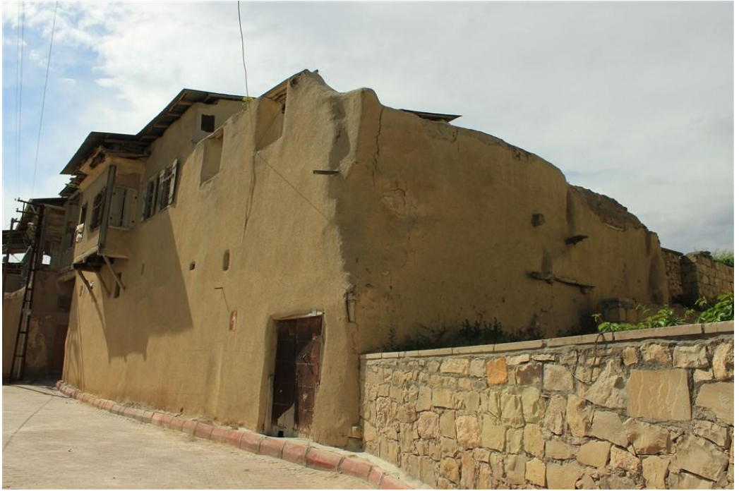
Foto 28. 2 - Mehmet Çiftçi Evi Güneydoğu Cephe
