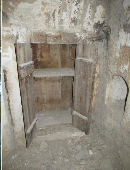
Foto 12. 11 - Ahşap Dolap ve Niş
