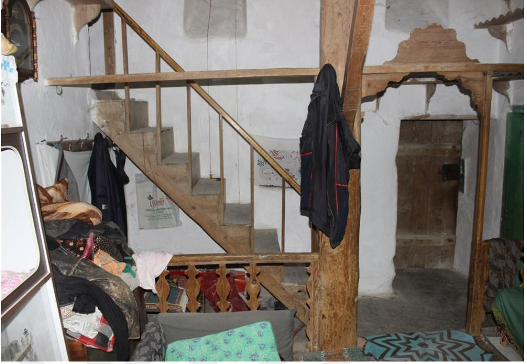
Foto 20. 11 - Zemin Kat Oda Batı Cephe
