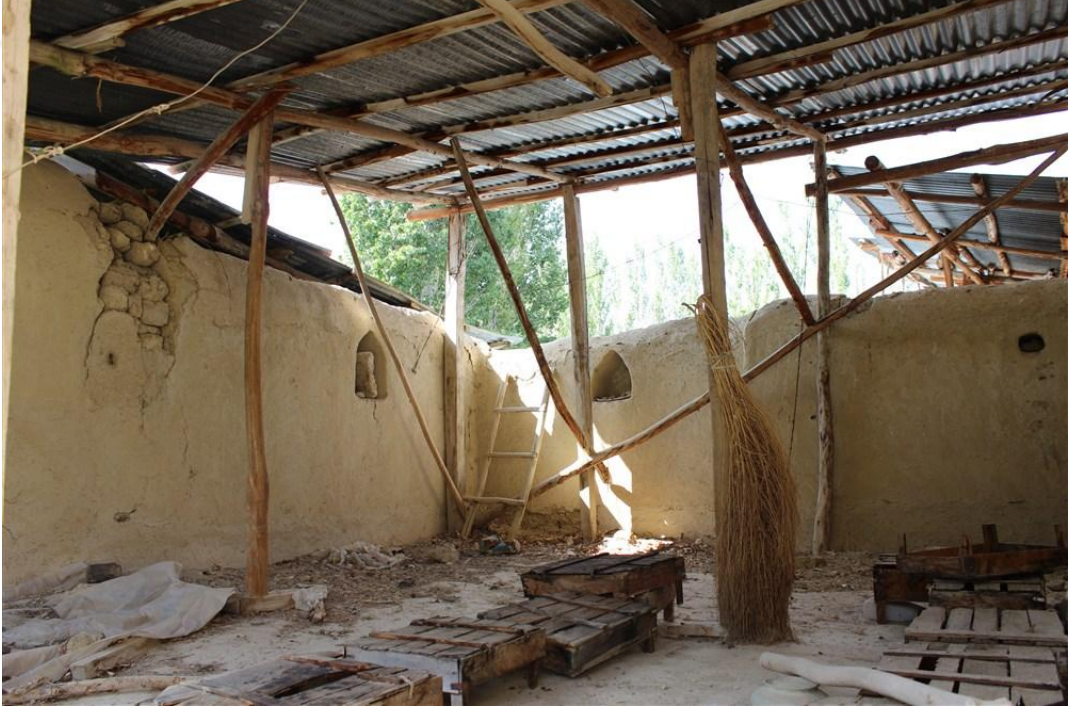
Foto 22. 25 - Yarı Açık Dam
