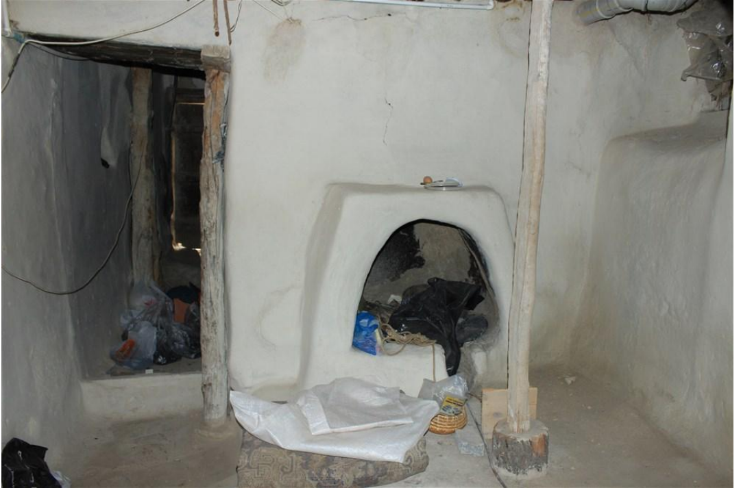
Foto 28. 8 - Zemin Kat Oda ve Kerpiç Ocağı
