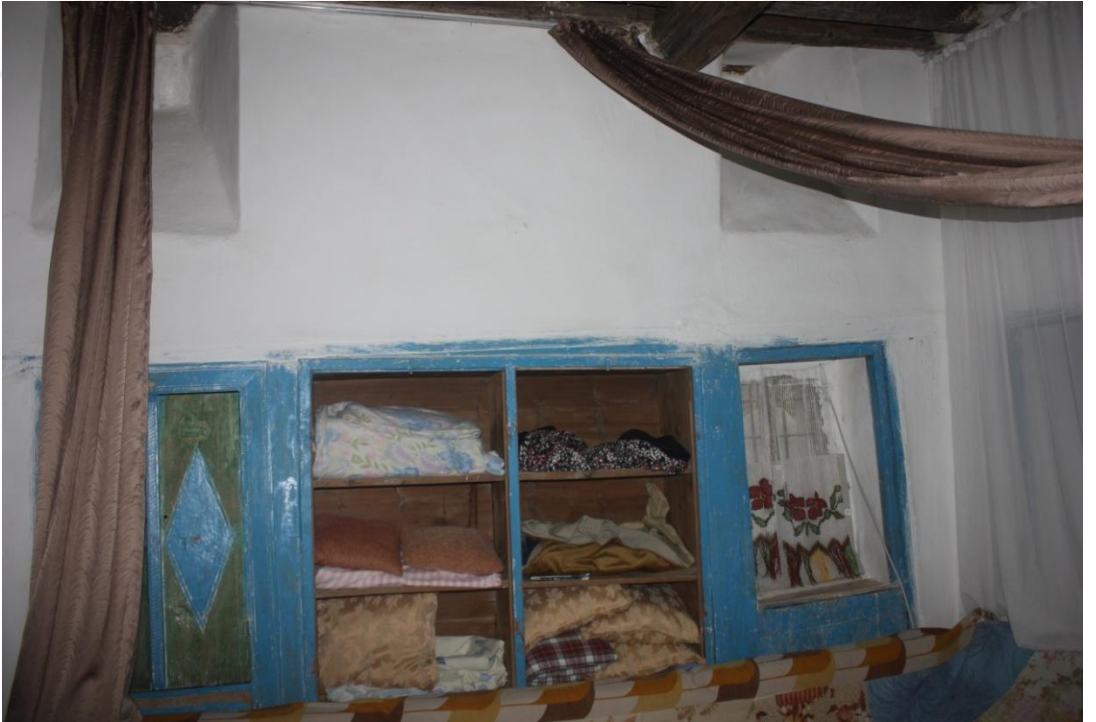
Foto 26. 31 - Ahşap Dolap ve Sağır Pencere Düzenlemesi
