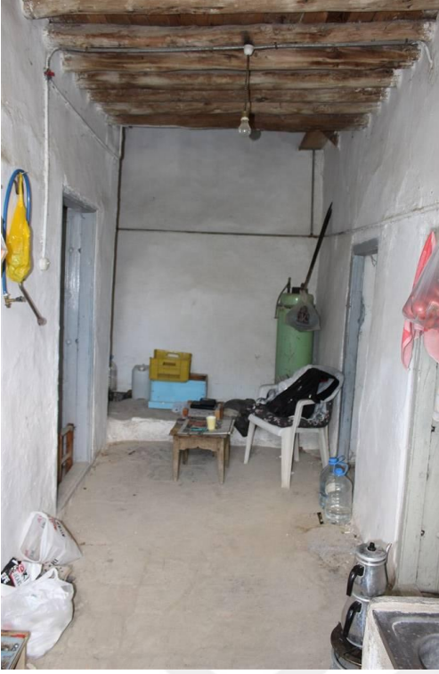
Foto 16. 12- Zemin Kat Sofa Doğu Cephe
