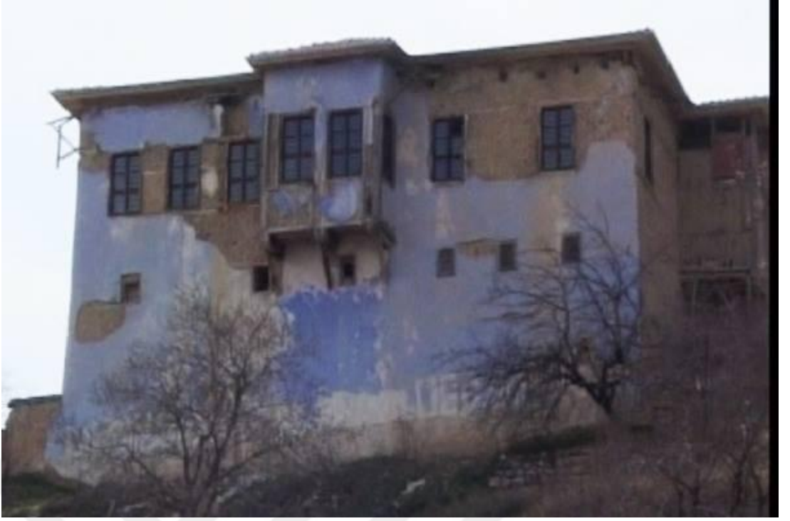
Foto 27. 3 - Paksoy Konağı Restorasyon Öncesi Doğu Cephe
