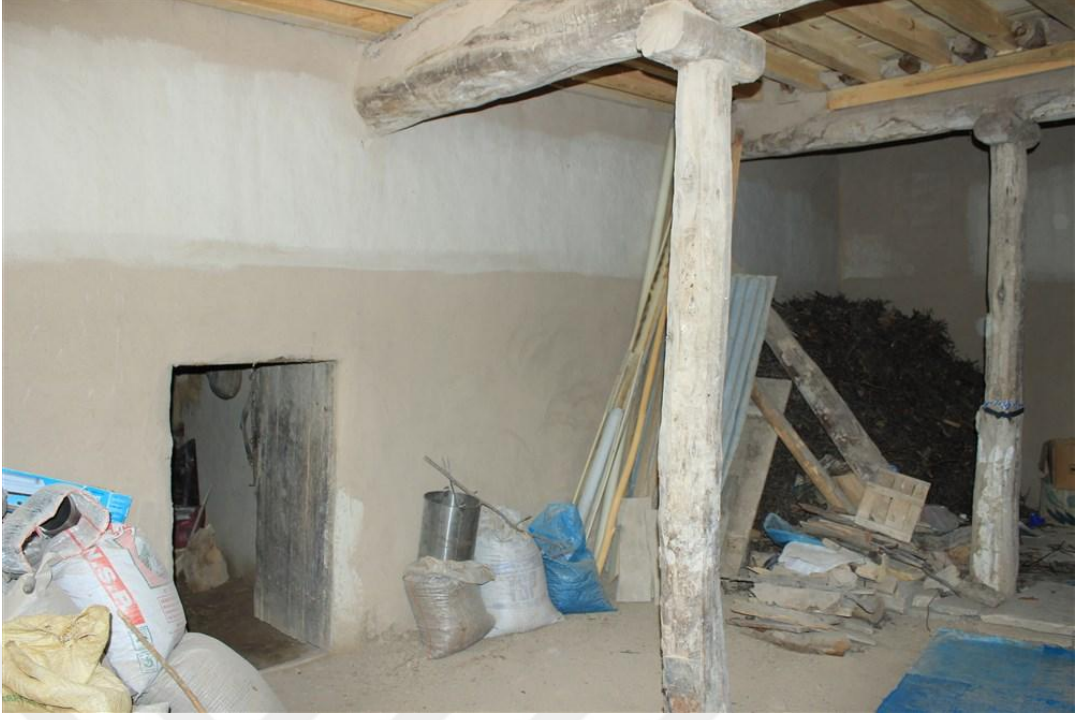
Foto 31. 7 - Zemin Kat Ahır/Depo Doğu Cephe
