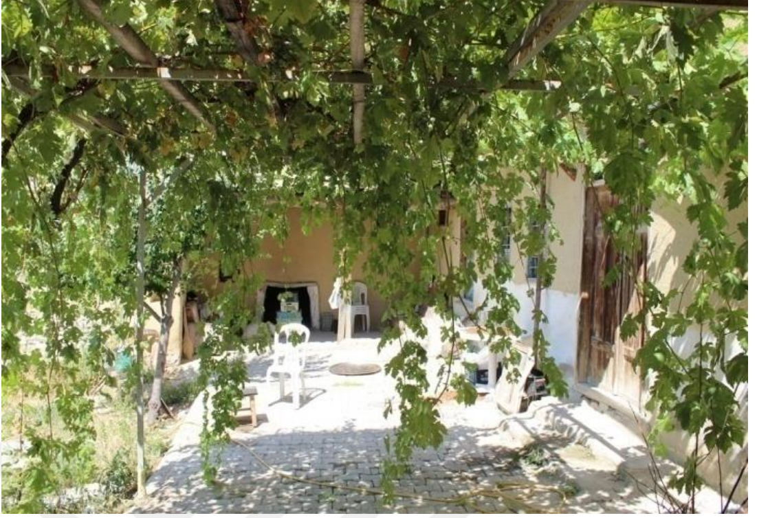
Foto 16. 10 - Taşlık Kuzey Cephe
