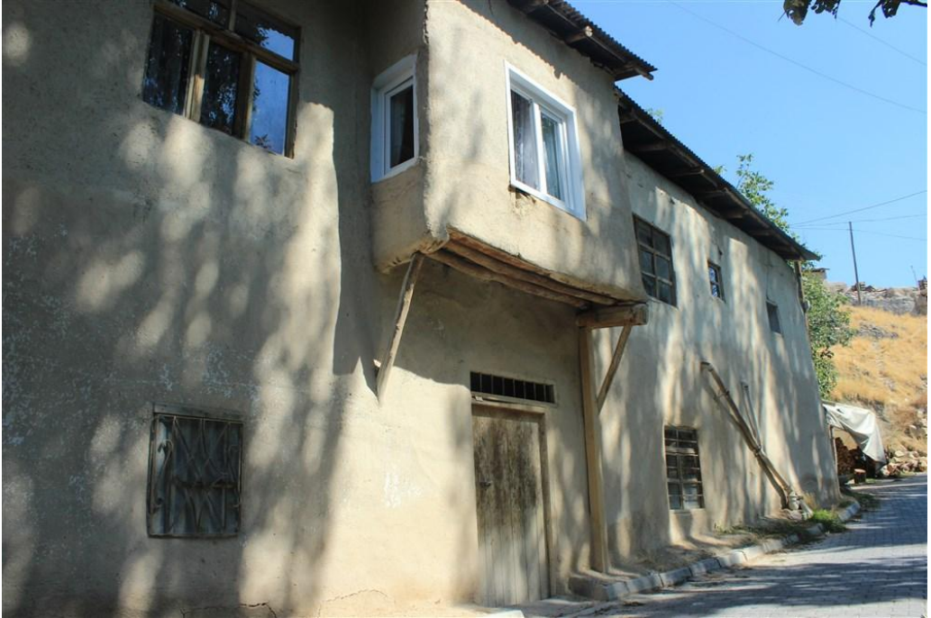
Foto 38. 2 - Fevzi Arslan Evi Güney Cephe
