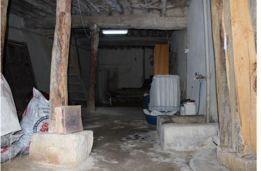
Foto 29. 8 - Zemin Kat Aralık Batı Cephe
