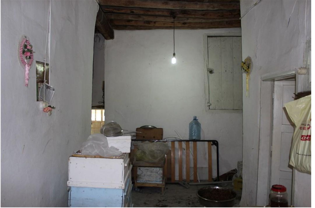
Foto 16. 23 - Birinci Kat Sofa Batı Cephe
