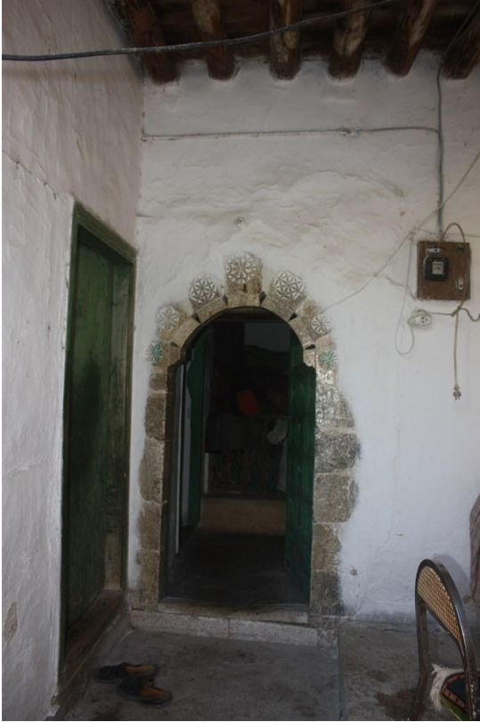
Foto 20. 9 - Zemin Kat Giriş Cephesi
