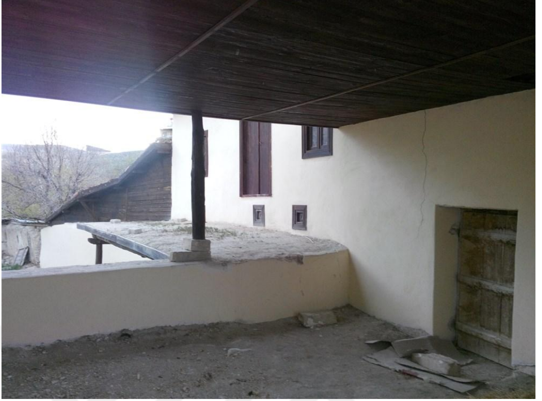
Foto 12. 17 - Gezemek Güneybatı Cephe
