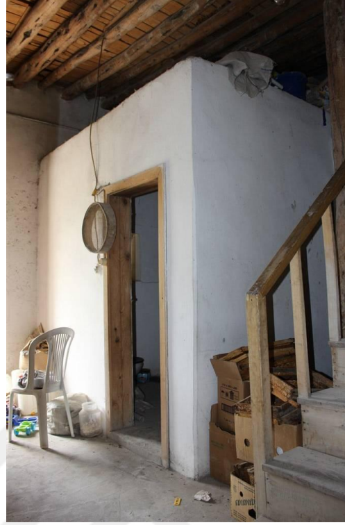
Foto 16. 19 - Zemin Kat Aralık
