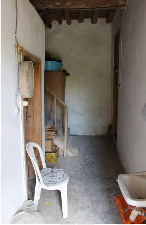
Foto 16. 18 - Zemin Kat Aralık
