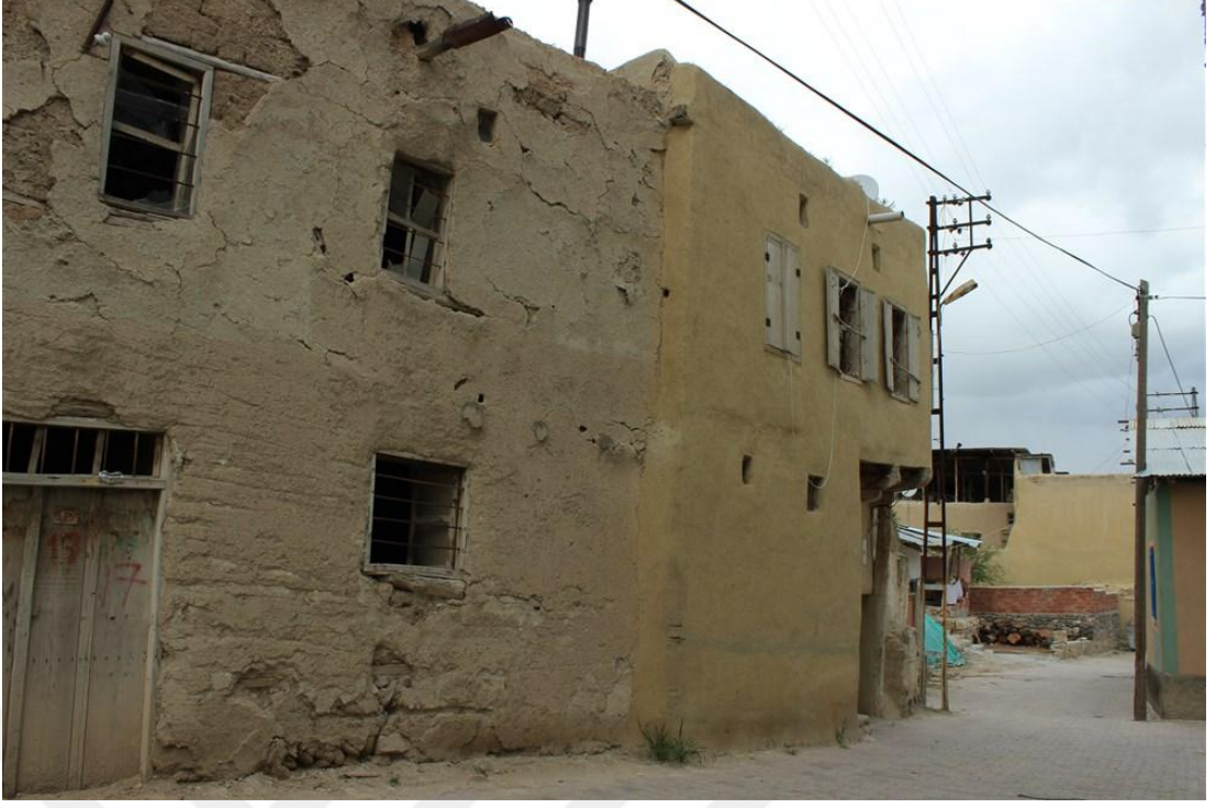
Foto 29. 5 - Doğu Cephe ve Komşu Yapı
