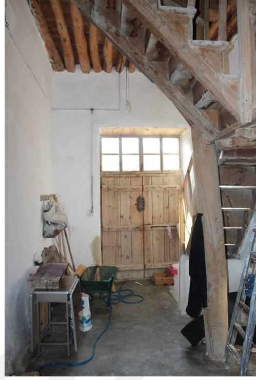
Foto 15. 12 - Zemin Kat Aralık
