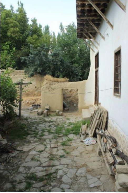
Foto 15. 6 - Taşlık Kuzey Cephe
