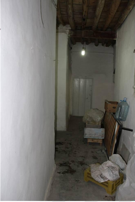
Foto 16. 24 - Sofa Güney Cephe
