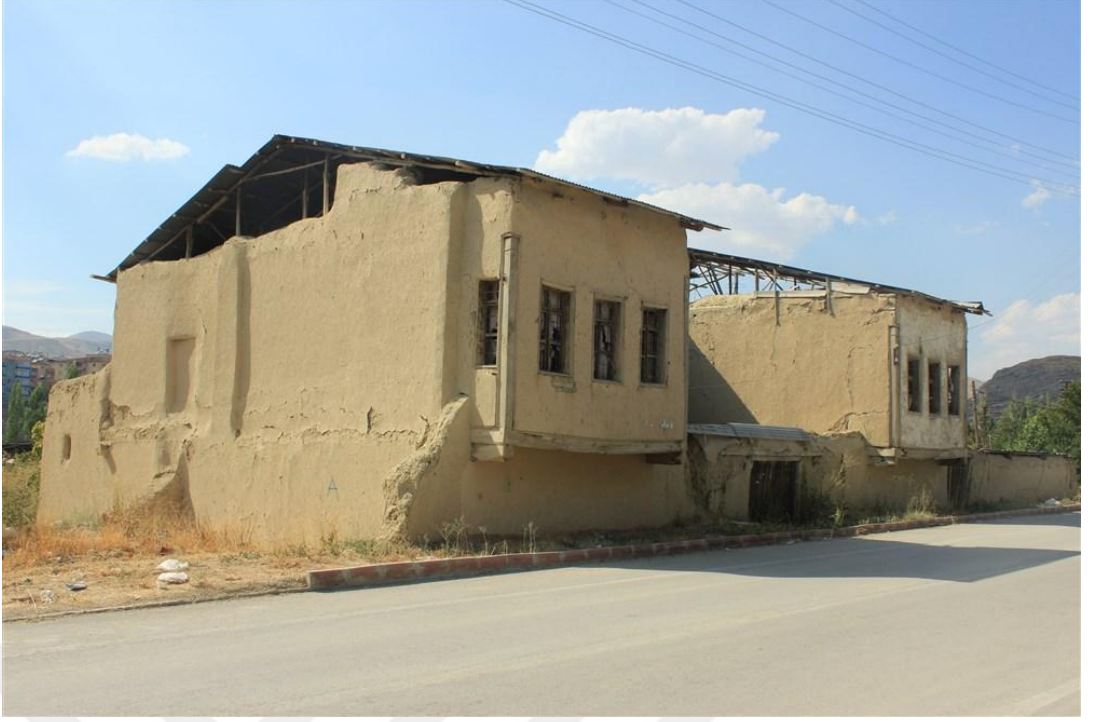
Foto 17. 5 - Yücel Soylu Evi ve Komşu Yapı Güneydoğu Cephe
