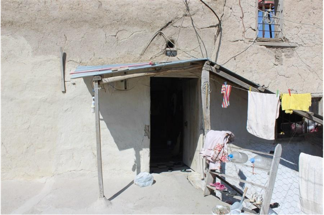
Foto 33. 12 - Birinci Kat Giriş Cephesi
