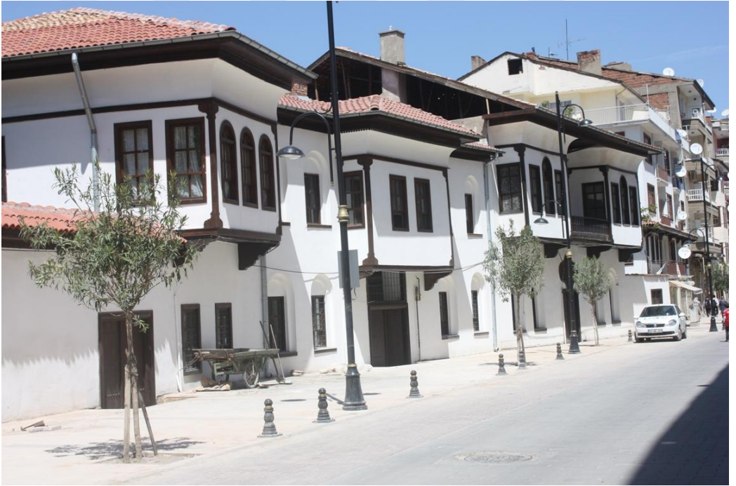
Foto 81 - Saray Mahallesi Sinema Caddesi Evleri
