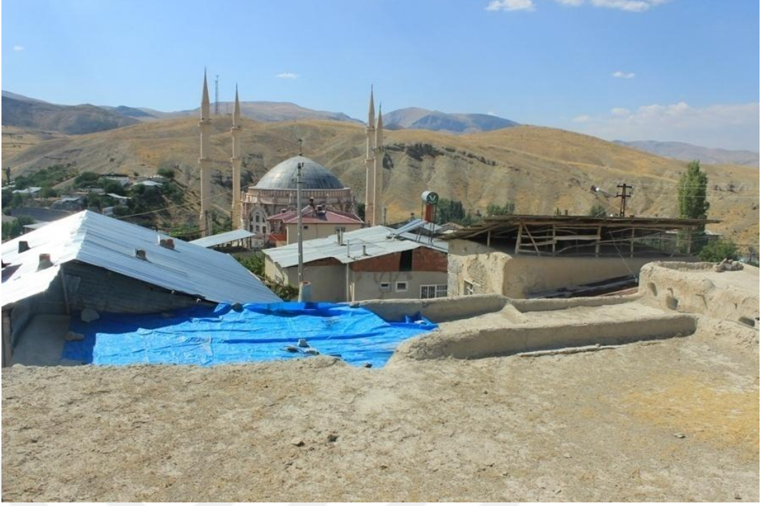
Foto 37. 9 - Erdem Sokak Evleri ve Asaf Erdem Evi Toprak Dam
