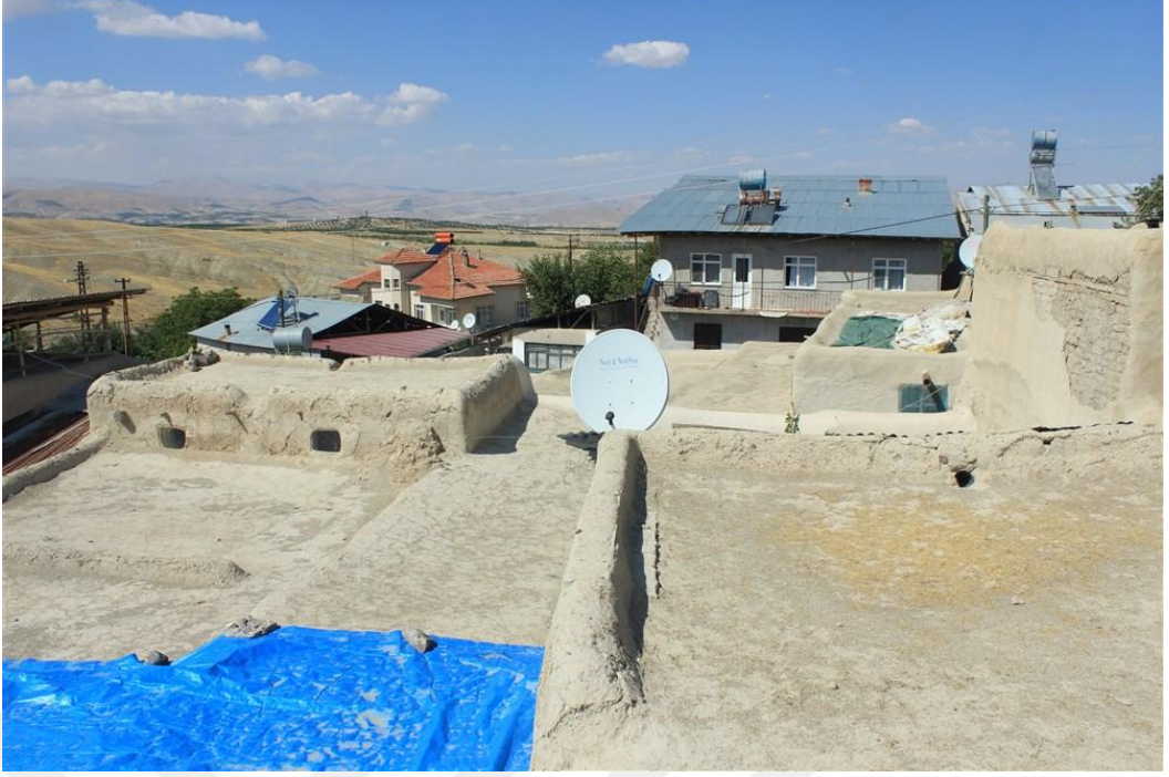
Foto 35. 12 - Erdem Sokak Evleri ve Ali Şen Evi Toprak Dam
