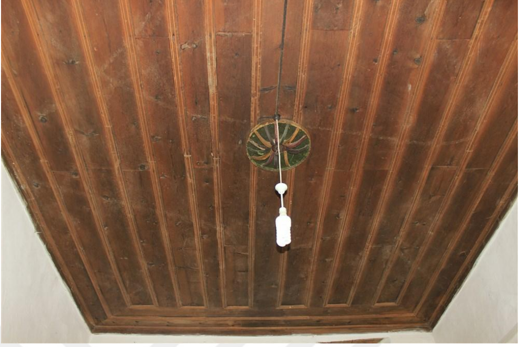
Foto 15. 21 - Kış Odasının Düz Tavanı ve Tavan Göbeği
