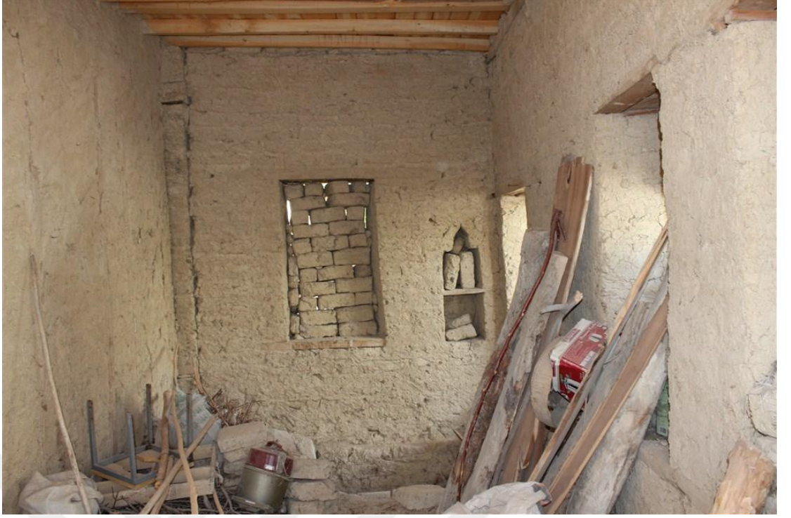
Foto 22. 9 - Birinci Kat Oda Batı Cephe
