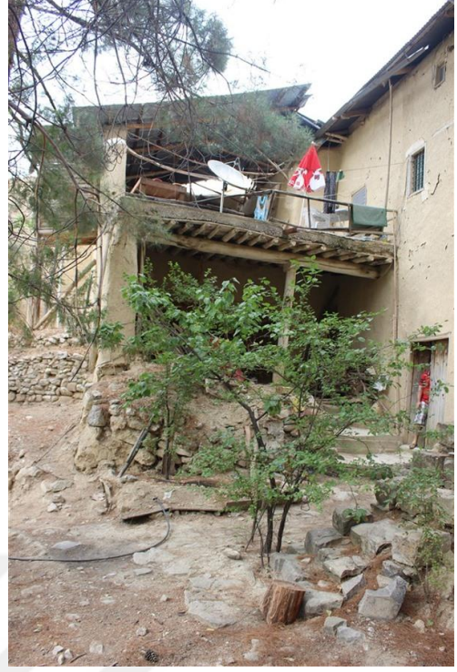
Foto 21. 18 - Avlu Kuzey Cephe
