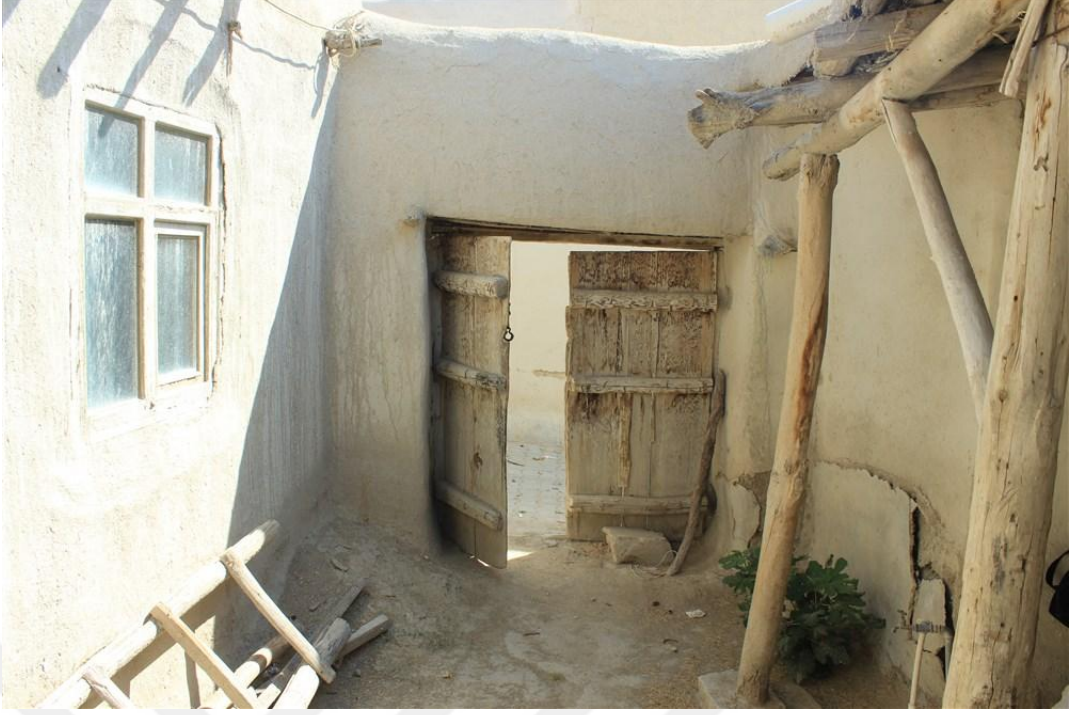
Foto 36. 6 - Avlu Güney Cephe
