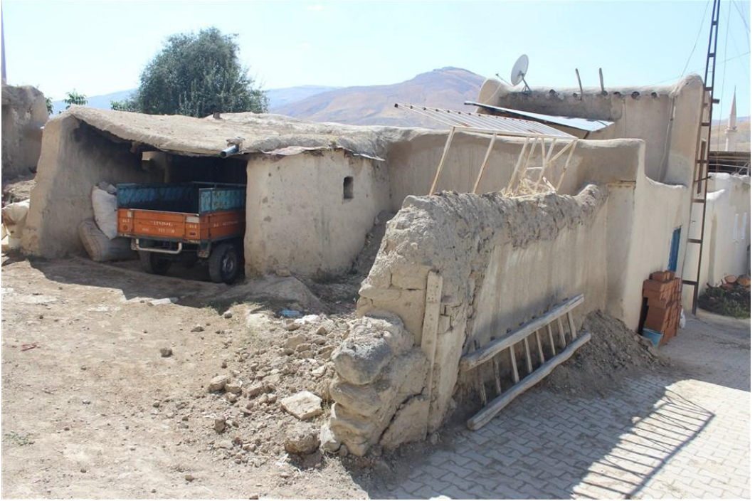
Foto 35. 8 - Ali Şen Evi Kuzeydoğu Cephe
