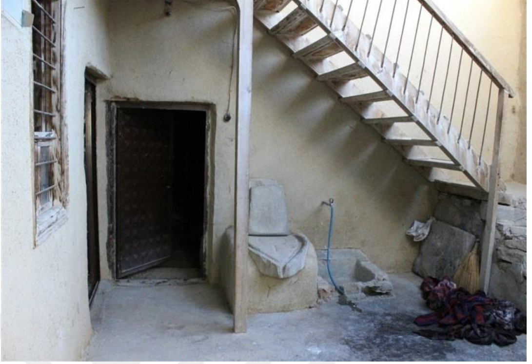
Foto 13. 5 - Avlu Güney Cephe
