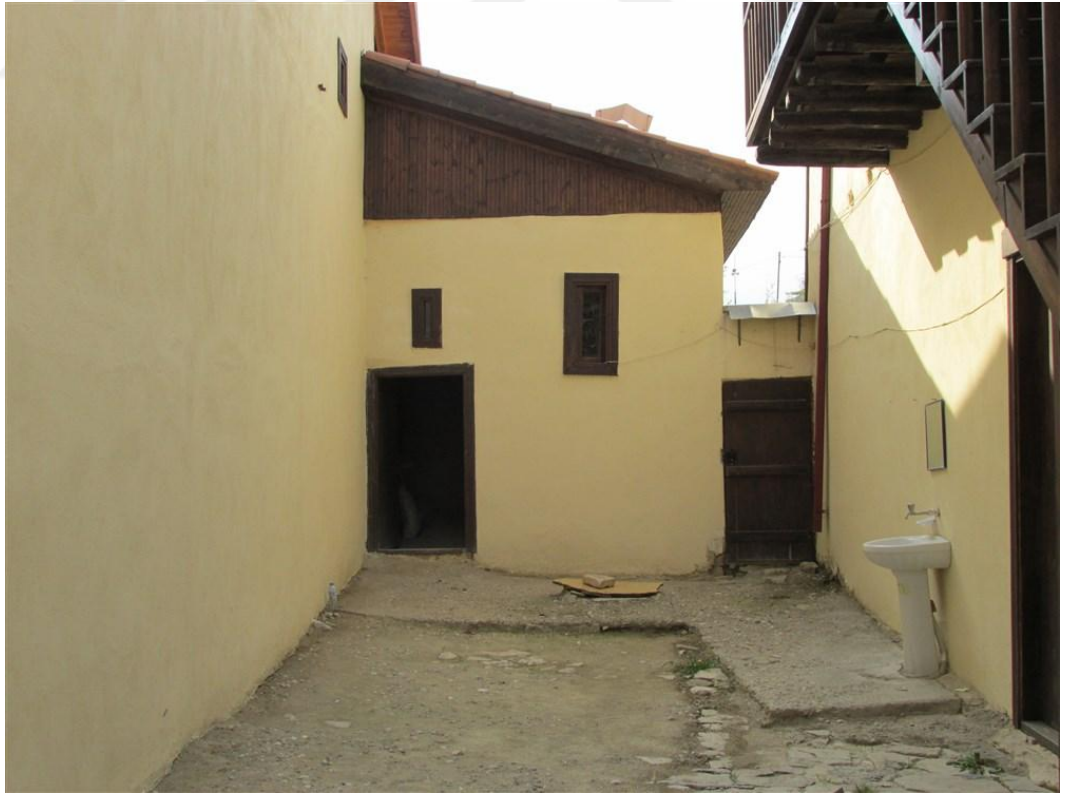
Foto 9. 12 - Avlu Batı Cephe
