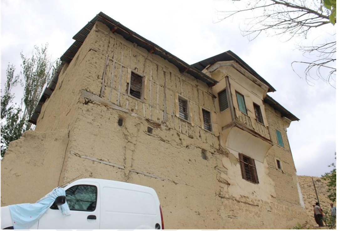
Foto 21. 3 - Germiterlioğlu Evi Doğu Cephesi
