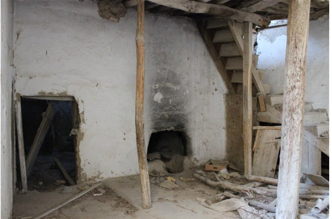
Foto 14. 9 - Avlu Kuzey Cephe
