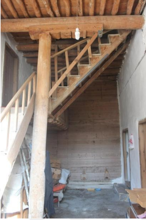
Foto 15. 11 - Zemin Kat Aralık
