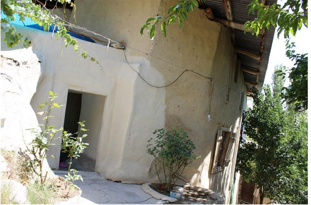
Foto 26. 4 - Birinci Kat Kuzey Giriş Cephesi
