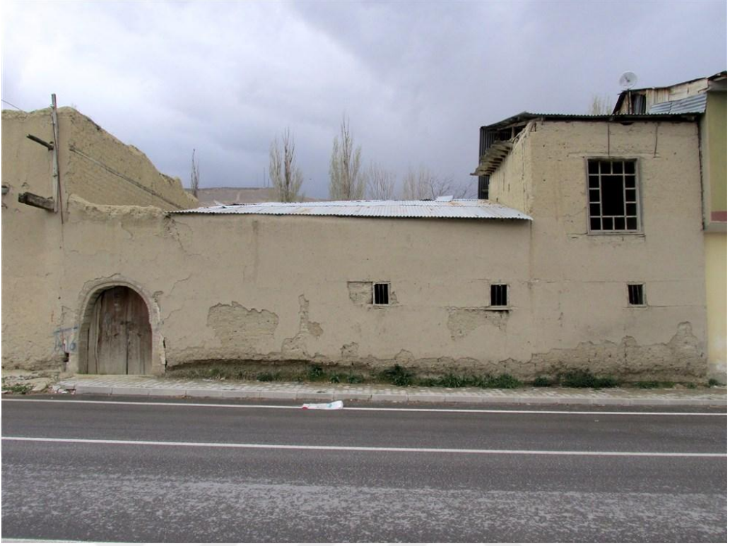
Foto 14. 3 - Müdür Ahmet Kaya Evi Doğu Cephe
