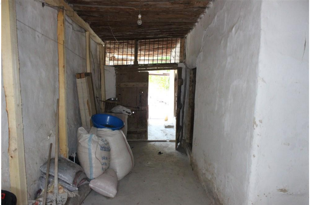
Foto 23. 8 - Zemin Kat Aralık
