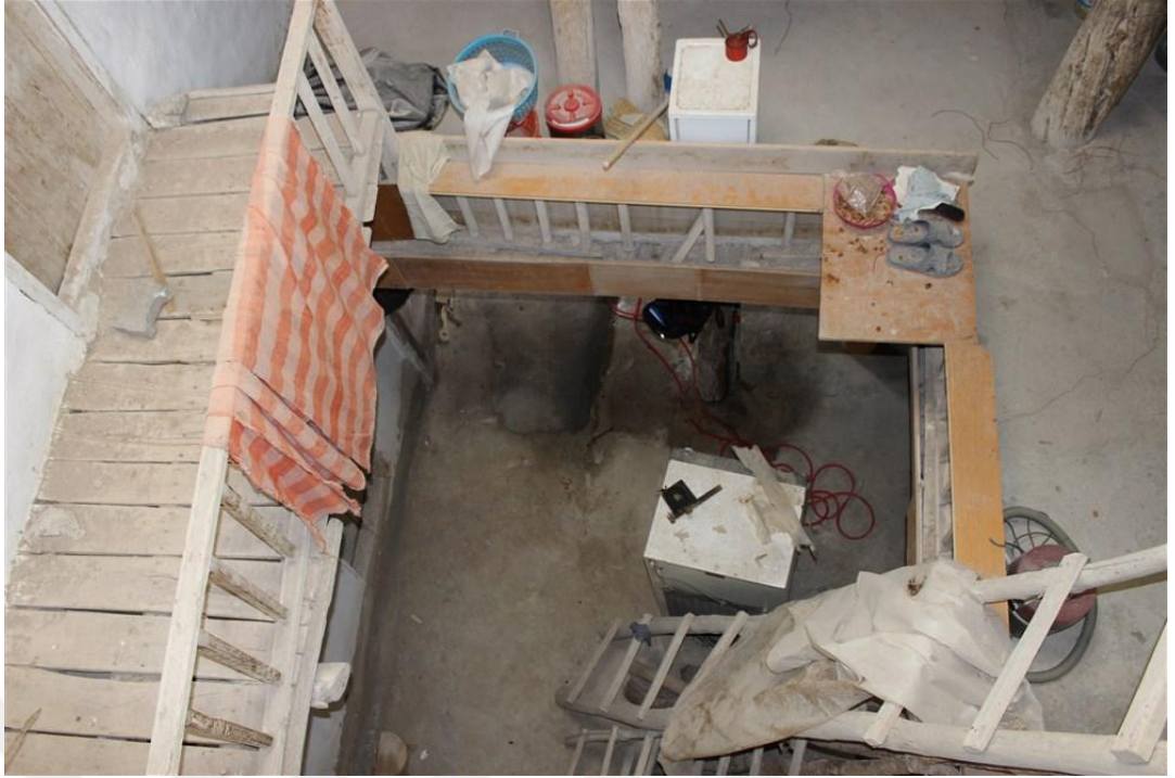
Foto 30. 16 - Çatı Katından Zemin ve Birinci Kata Bakış
