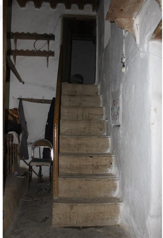
Foto 20. 13 - Zemin Kattan Ara Kata Çıkış
