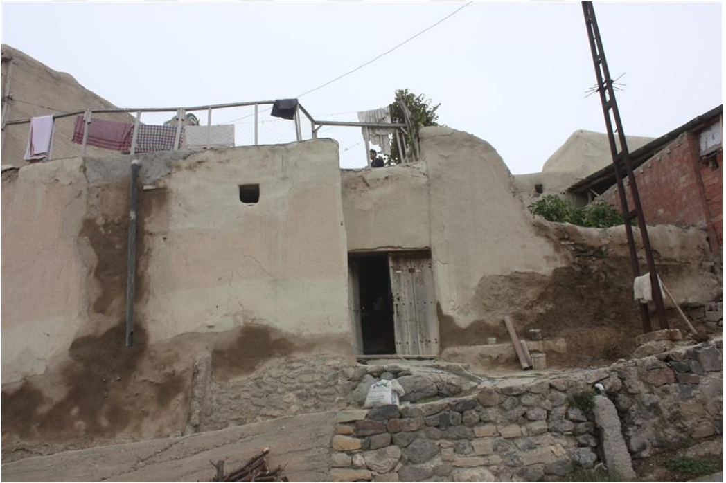
Foto 33. 4 - Güney Cephe Giriş Mekânı
