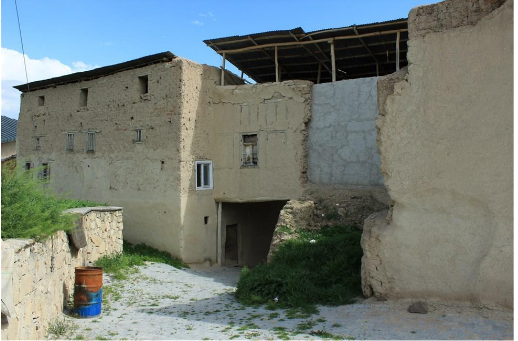
Foto 28. 4 - Kuzeybatı Cephe ve Komşu Yapının Selamlığı
