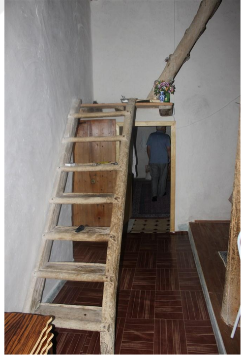
Foto 24. 14 - Çatı Katı Çıkış Merdiveni
