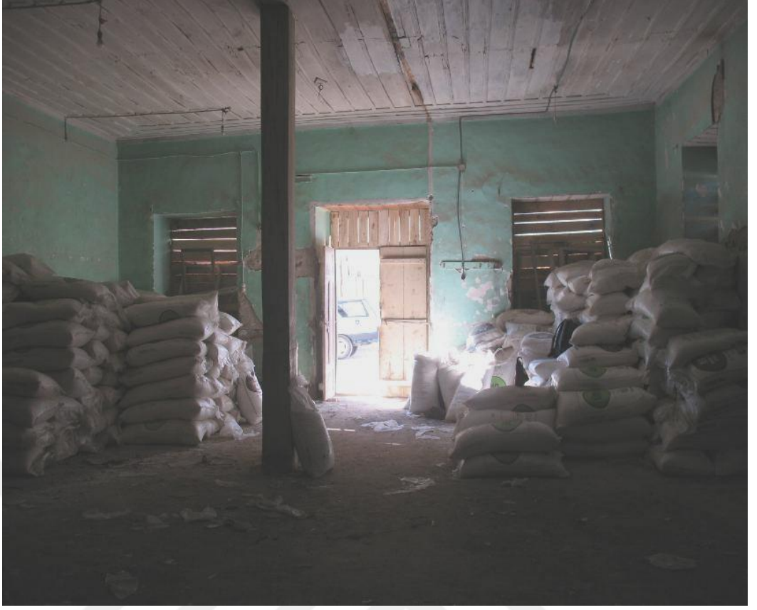
Foto 18. 7 - Zemin Kat Batı Cephe
