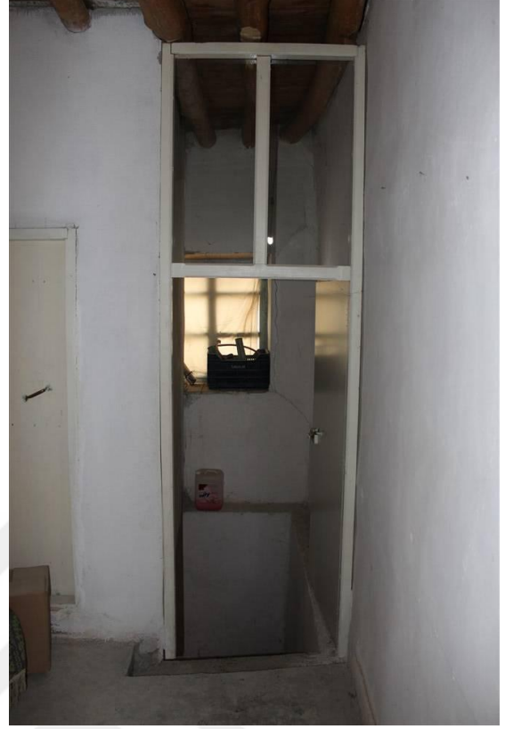
Foto 16. 25 - Zemin Kata İniş Mekânı
