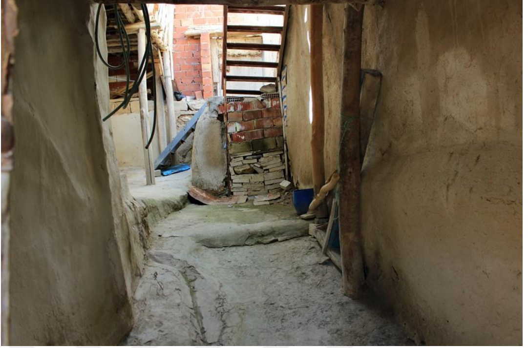
Foto 28. 23 - Avluya Giriş Kuzey Cephe
