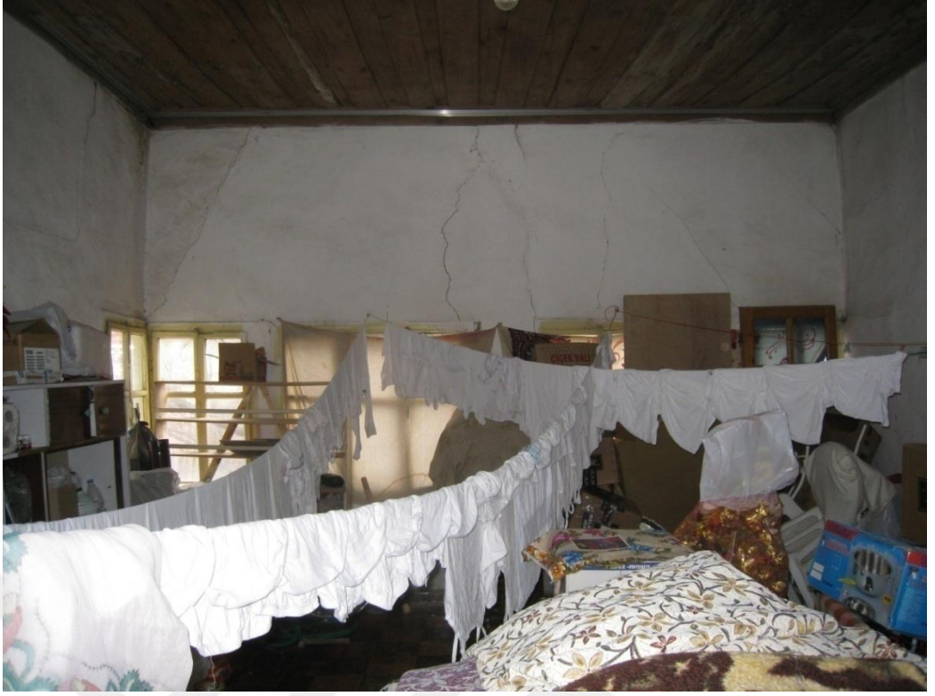
Foto 19. 8 - 8 Nolu Ev Birinci Kat Batı Cephe
