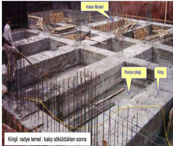
Şekil 3.18. Kirişli radye temel imalatı, kalıbı, beton dökümü ve blokaj işlemi (URL-6).
