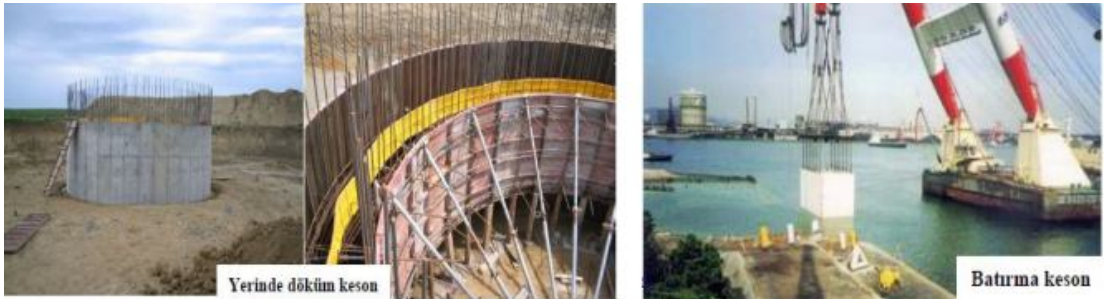
Şekil 2.7. Yerinde döküm keson, batırma keson (URL-2).
