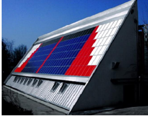
Şekil 1.13. Isı geri kazanımı ile havalandırılan PV [42]
