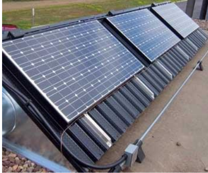
Şekil 1.5. PV/T hava geçişli kolektör
