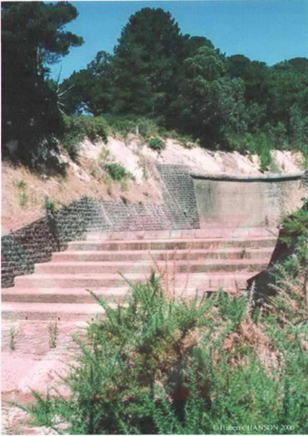
Şekil 4.7 Malmsbury Barajı - Avustralya
