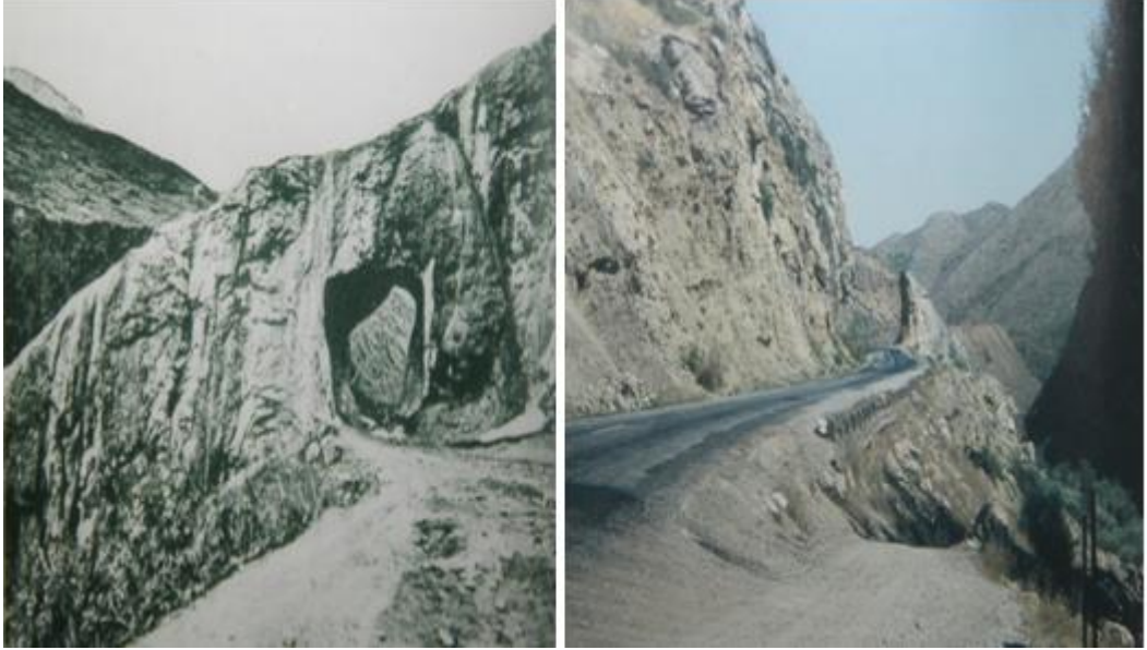
Foto 39. Bitlis Deliklitaş (Semiramis) Kaya Tüneli'nin eski ve yeni görünümü
