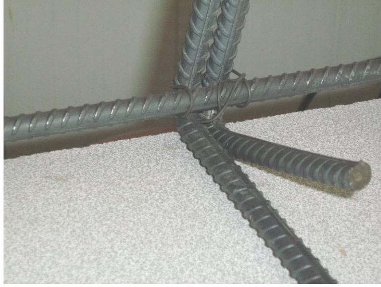
Resim 4.1. Çelik Donatının Çelik Teller ile Bağlanması
