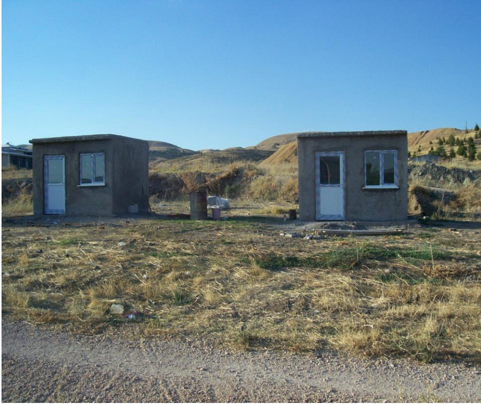
Şekil 2.1. Deneyler için inşa edilen test odaları.
