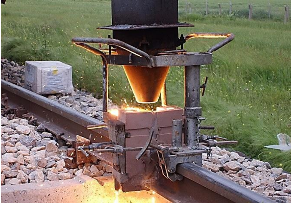
Şekil 3.10. Aliminotermite ray kaynağı [27].
