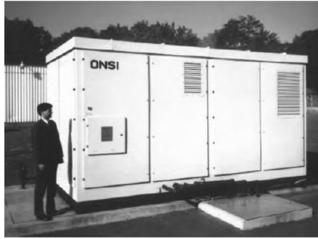
Şekil 2.7 200 kW'lık FAYP kojenerasyon sistemi
