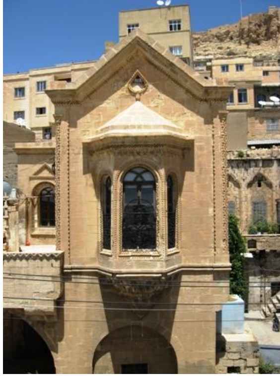
Fotoğraf 3.26. Üst katta sokağa doğru üçgen yapılan çıkma örneği
