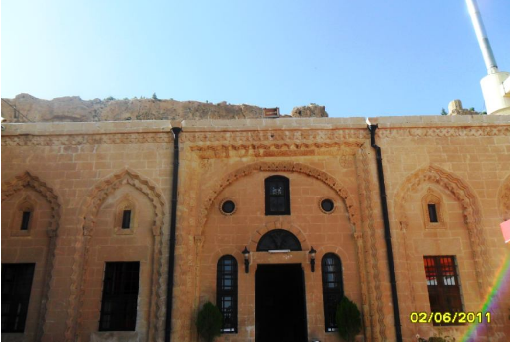
Fotoğraf 3.42. Dam ve terasta biriken yağmur sularının atılması
