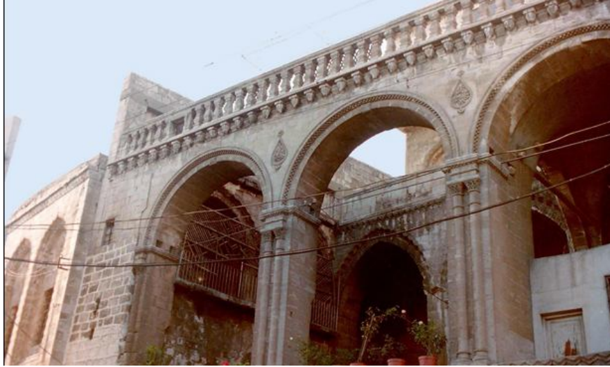
Fotoğraf 3.8. Şahkulubey konağının eyvan ve revakları
