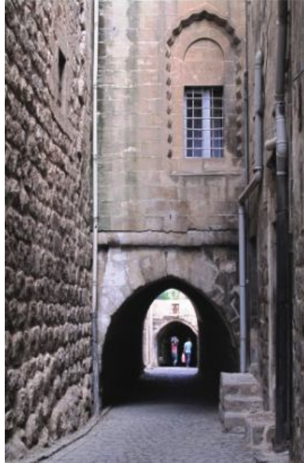
Fotoğraf 3.2. Kabaltılı üzerinde bulunan evin sokak cephesi
