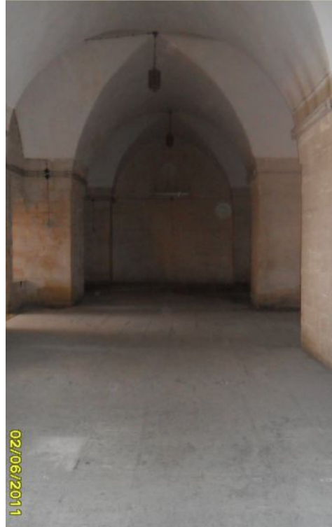
Fotoğraf 4.2. Yan yana getirilen kemerlerle oluşturulan uzun bir mekan
