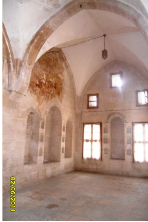
Fotoğraf 4.1. İki Çapraz tonoz sistemini bir kemerle birleştirilmiş
