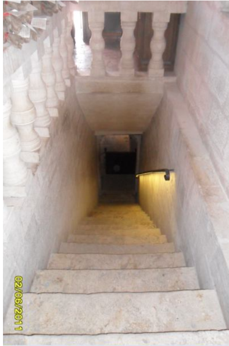
Fotoğraf 3.20. İç mekândaki merdiven örneği
