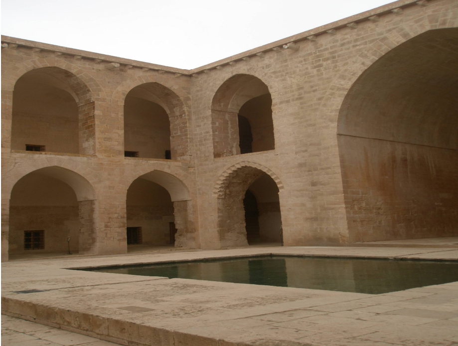
Fotoğraf 3.28. Kasımiye medresesinden sivri kemerli olan revaklar
