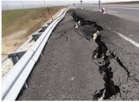
a) Stripping of bitumen layer (Karayolu Haber, 2013)
