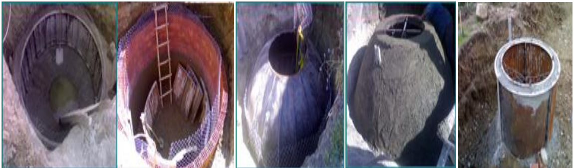
Şekil 1.33. Biyogaz üreteç inşasından görüntüler (URL-2, 2010).
