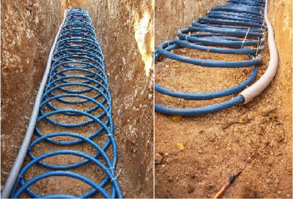
Şekil 2.2. Slinky (spiral) olarak serilmiş boru görüntüsü
