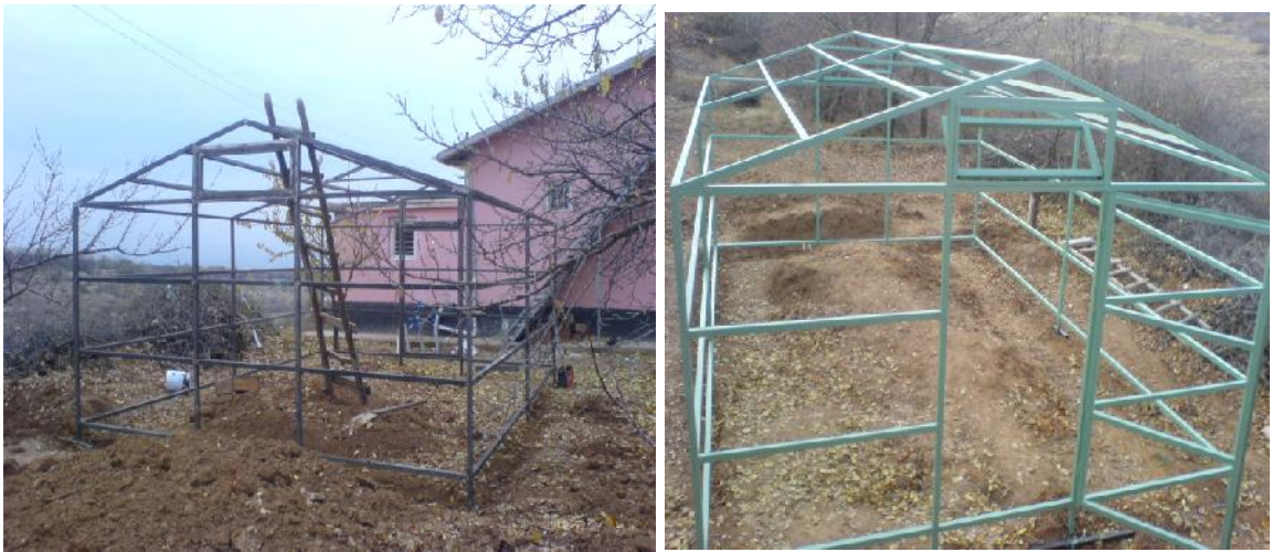
Şekil 2.5. Sera iskeletinin kurulumu
