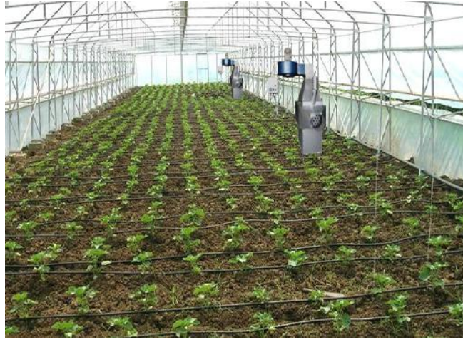
Şekil 1.2. Biyogazın sera ısıtılmada kullanımı
