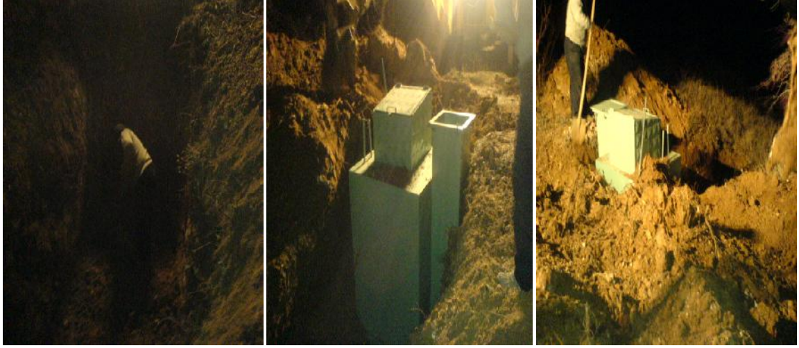
Şekil 2.10. Biyogaz tankının çukura yerleştirilmesi
