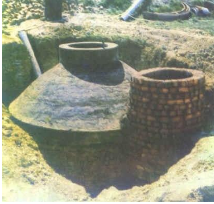
Şekil 1.11. Sabit kubbeli (Çin tipi) biyogaz tesisi (Bilgin, 2003).
