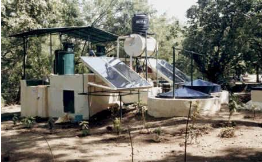
Şekil 1.12. Güneş enerjisi ile biyogaz tesisinin ısıtılması (Bilgin, 2003)
