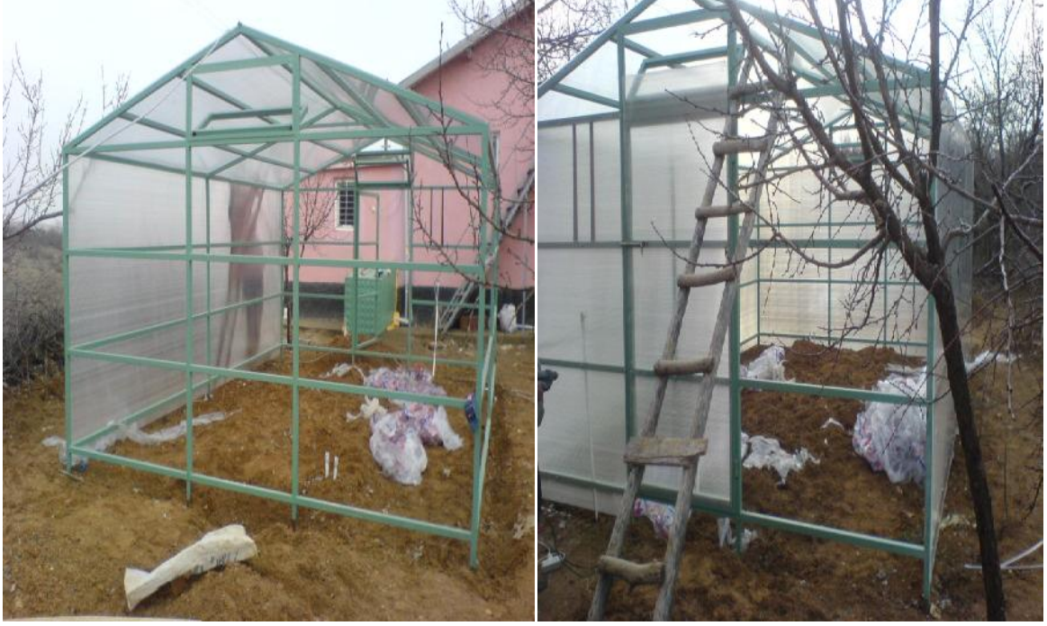
Şekil 2.6. Polikarbonun sera iskeletine montajı
