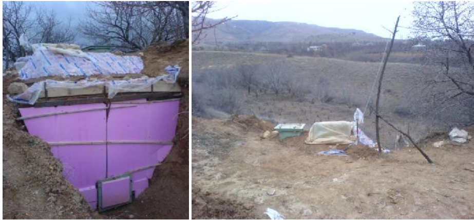
Şekil 2.11. Biyogaz tankının dış ortamdan yalıtılması
