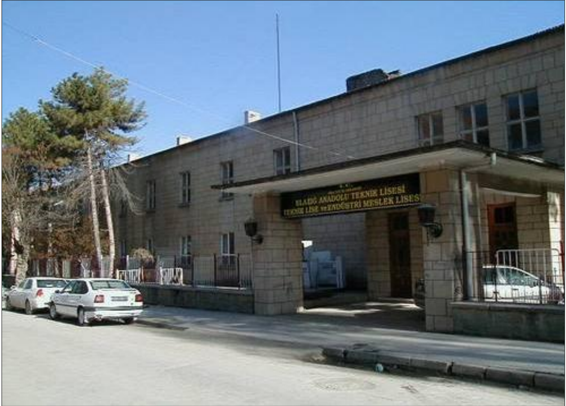
Şekil 6.3. Elazığ Merkez Teknik ve Endüstri Meslek Lisesi Binası
