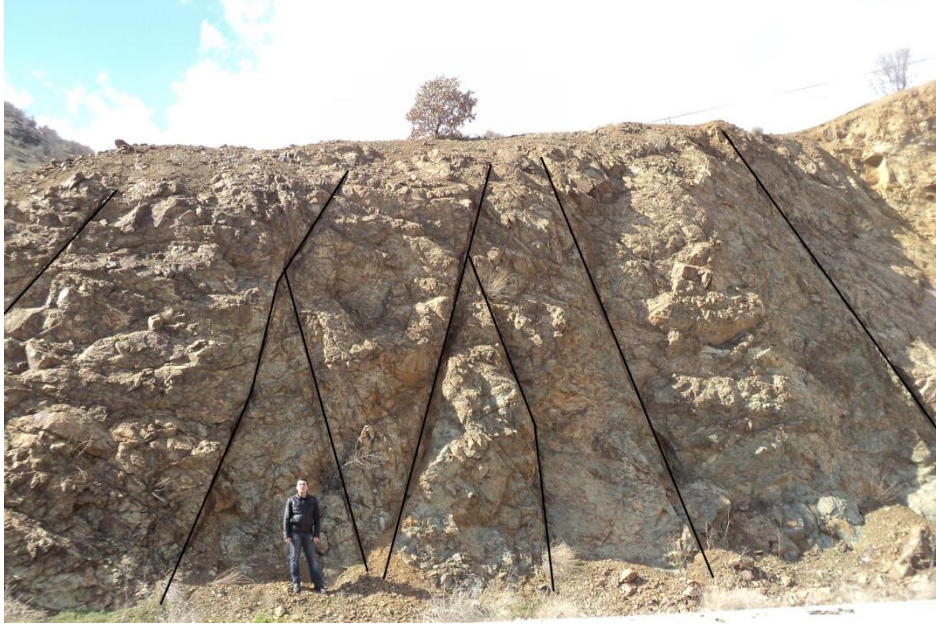
Şekil 4.9. İnceleme alanındaki eklem devamlılığın görünümü , bakış yönü K'den G'ye (E:38.452, B:38.848)
