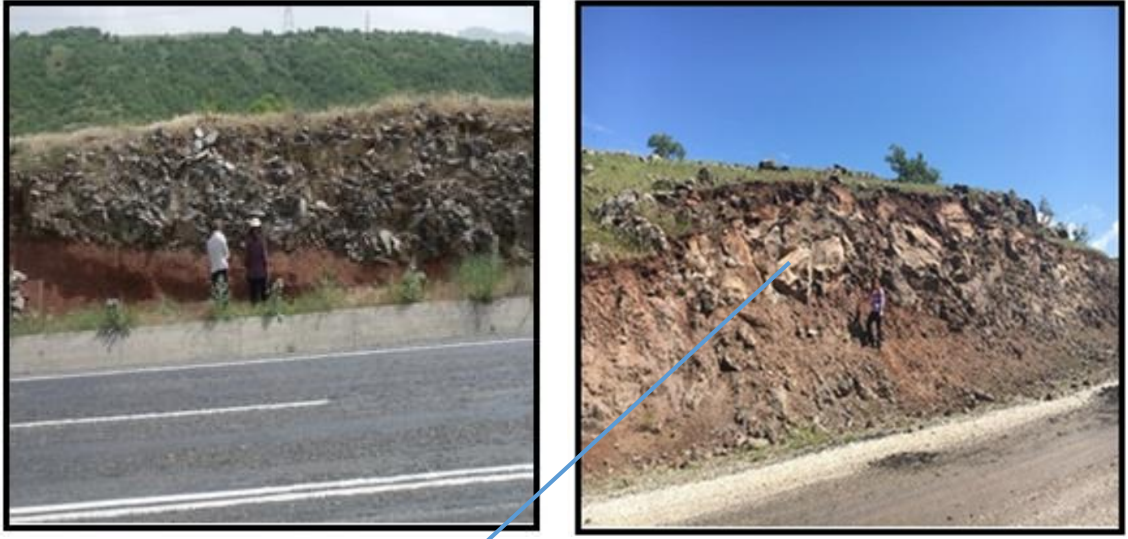
Şekil 3.7. Lav akıntısı ile tüfler arasındaki pişme zonunun görünümü (Karakoçan-Bingöl yolu).
