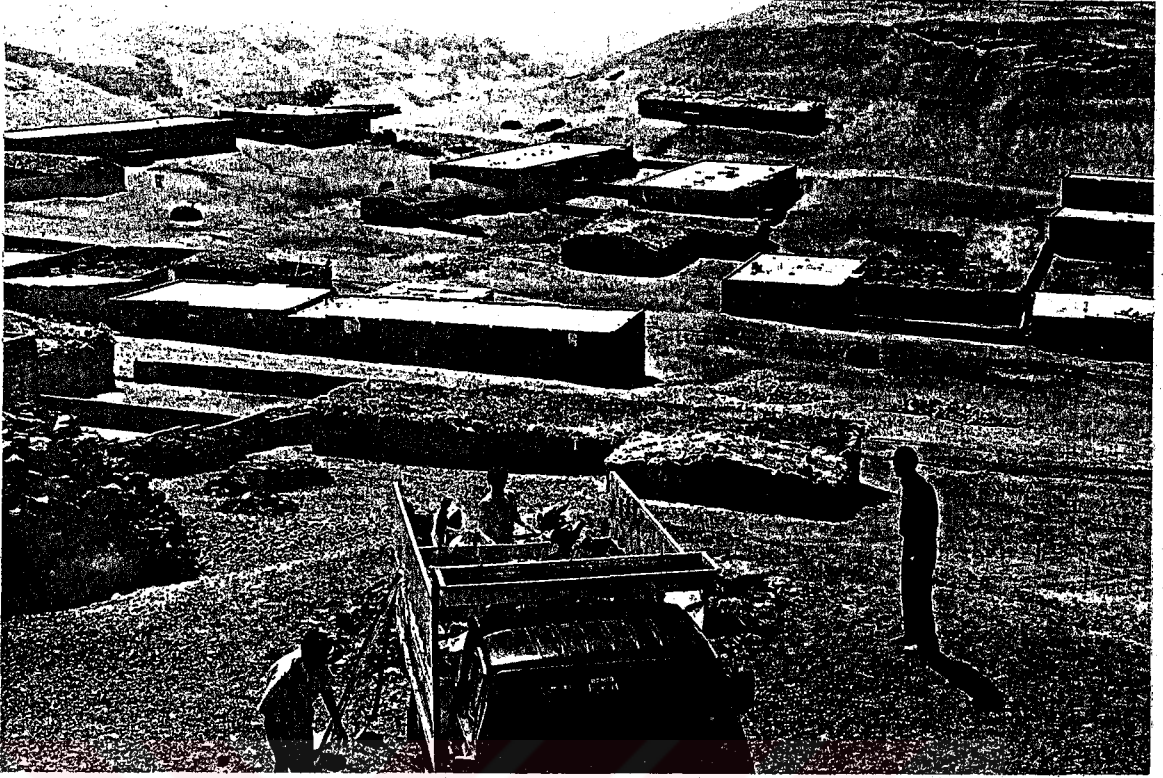
Foto- 23: Şehrin doğusunda, Şeyşemu tepesindeki gevşek yapılı Pliyo- Kuvaterner dolgular üzerinde yapılan gecekondu imar planından yoksun ve sağlıksızdır
