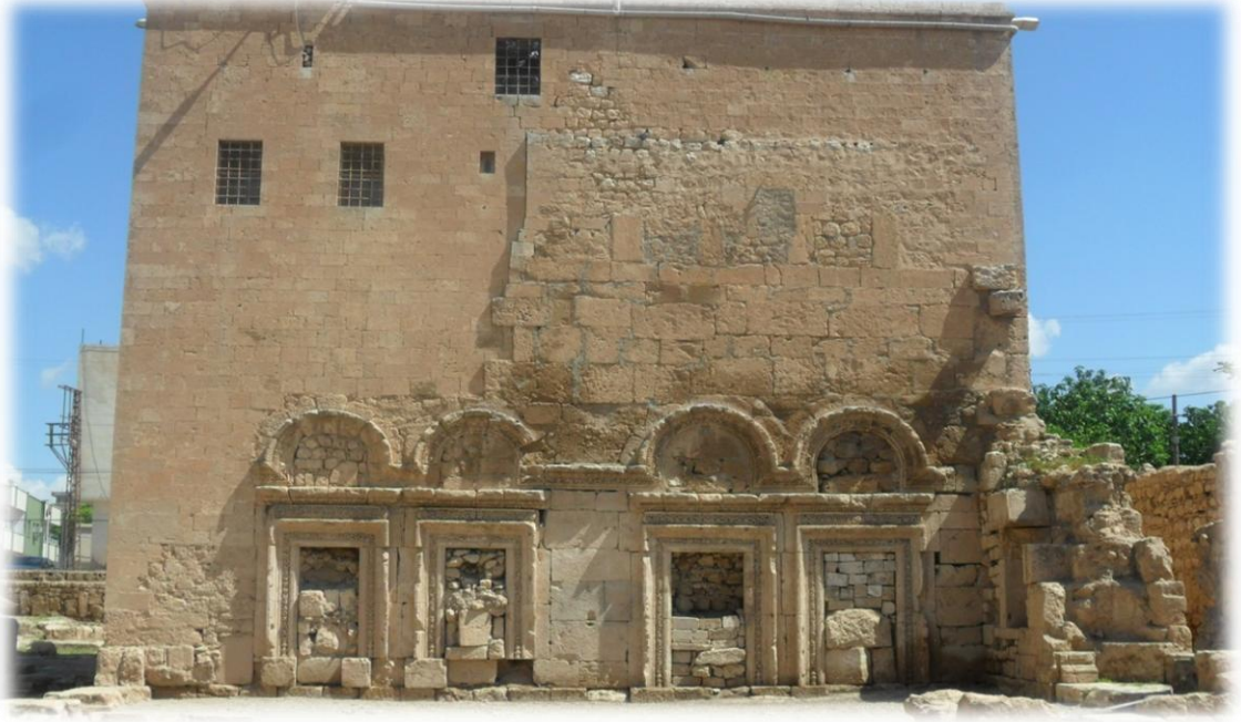
Resim 41: Mar Yakub Kilisesi'nin Dış Güney Cephesinin Bugünkü Görüntüsü (A. Kütük Arşivi, Mayıs- 2011)
