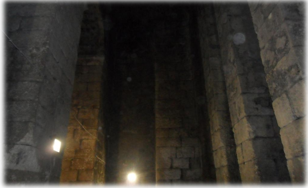
Resim 10: Dara'daki Depo (Silo)'nun İç Kısmı (Kolonlar) ( A. Kütük Arşivi, Mayıs-2011 )
