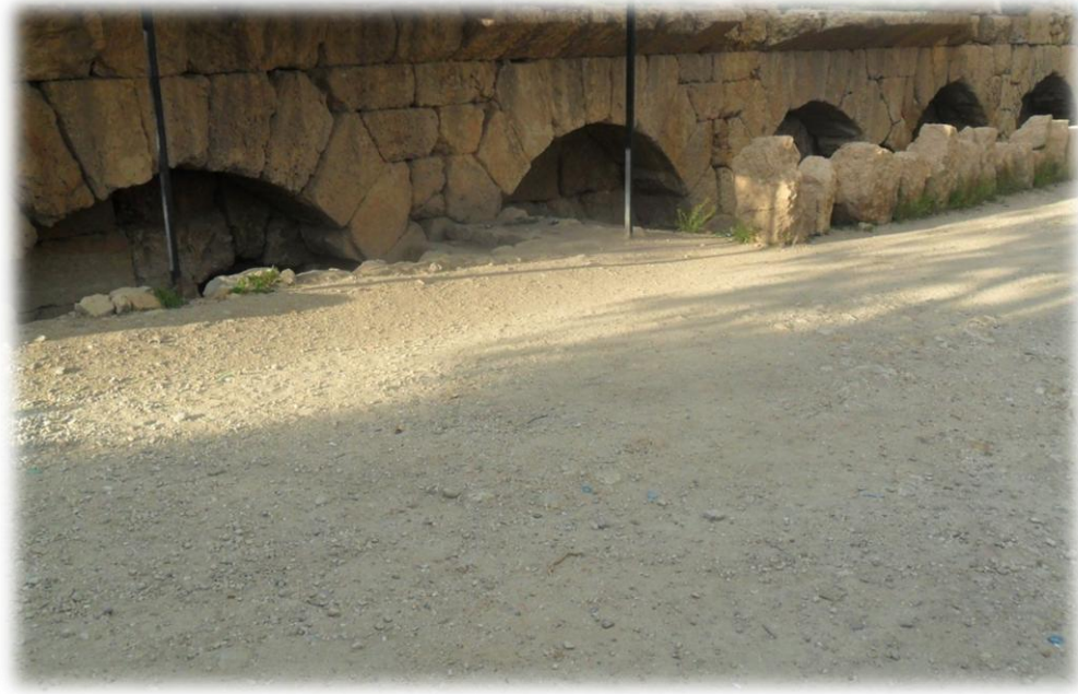
Resim 9: Dara'daki Depo (Silo) Giriş Kapı Kemerleri (A. Kütük Arşivi, Mayıs-2011)
