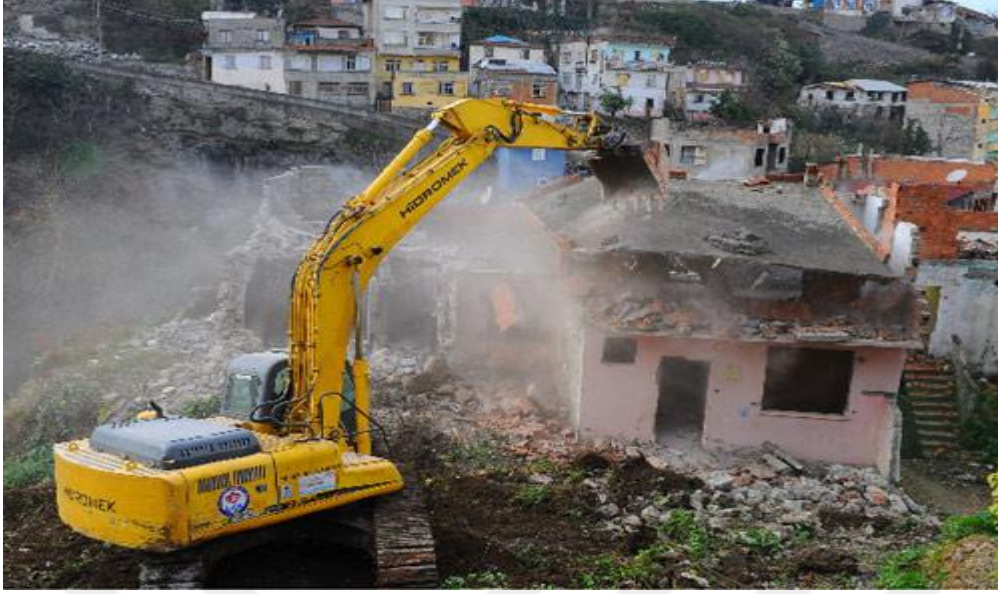
Şekil 5.10. Ekskavatörle Yıkım (www.gurkanharfiyat.com)
