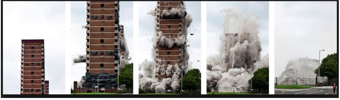
Şekil 5.14. Aşama Aşama Bir Binanın Patlatılarak Kendi Üzerine Çöküşü (www.cameronmcewan.wordpress.com)
