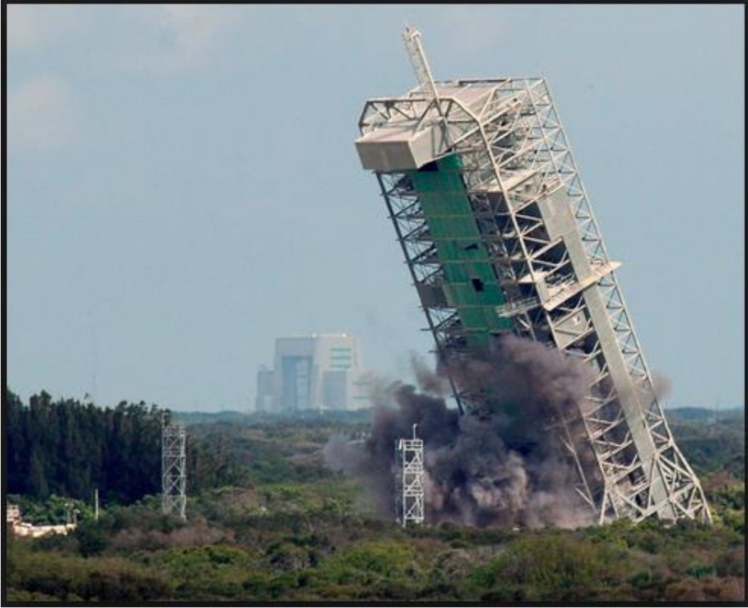
Şekil 5.16. Yana Yatırılarak Patlatılan Bir Bina ( www.theconnellgroup.co.uk )
