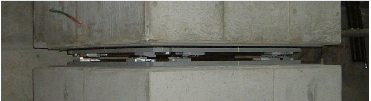
Şekil 3.10. Bir kolonun ortasında sürtünme esaslı sismik izolatör uygulaması
