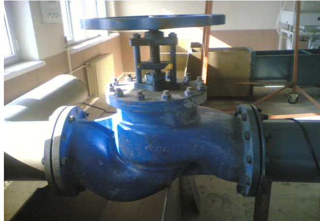
Şekil 5.5. Giriş debisinin ayarlandığı debimetrenin ön kısmındaki vana
