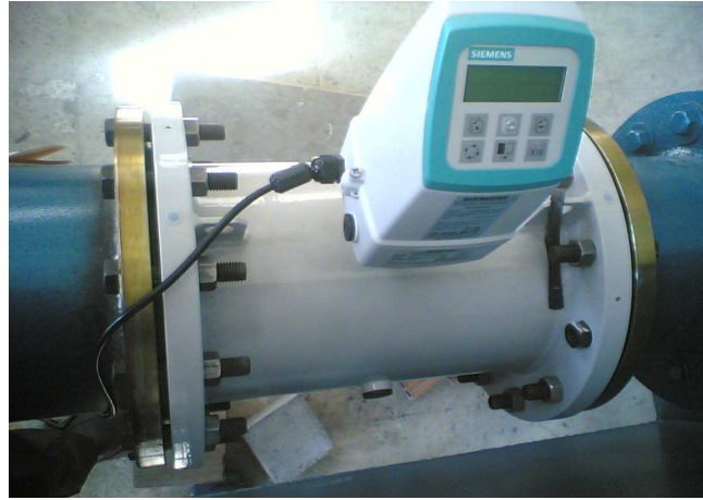
Şekil 5.4. Giriş debisi ölçen elektromanyetik debimetre
