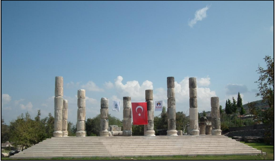
Resim 7: 2014 Yılı restorasyon sonrası tapınak. Ön cepheden görünüm.
